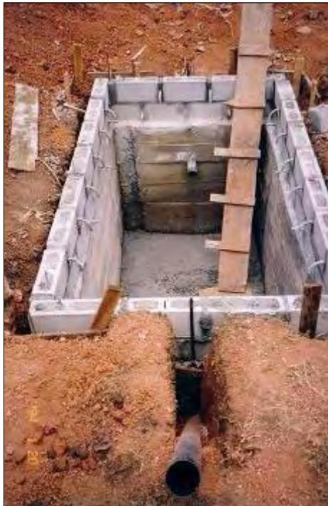
Luego, hay que hacer las paredes de cemento. La cantidad de materiales se puede variar para hacer esto, porque hay gente que usa diferentes proporciones de cemento, arena y piedra para hacer la mezcla. El Grupo de Mujeres normalmente usó 9 sacos de cemento, 2 metros de arena y 1 metro de piedra para hacer las paredes y para poner las tres filas de block de cemento.
