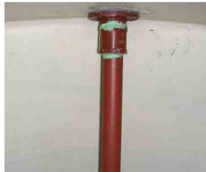
**Figura 8** – Vista interna caño camisa. Parte superior del tanque
