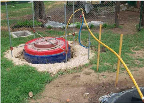
**Figura 34** – Conexión de biogás desde el digestor al gasómetro.
