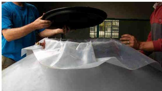
**Figura 15** – Colocación de silicona y nylon para evitar fugas de biogás.
