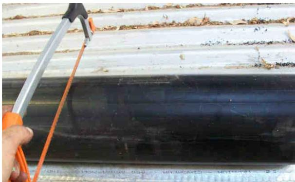
**Figura 23** – Corte de sección de caño de PVC.
