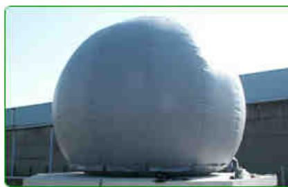
**Figura 2** Gasómetro de membrana
