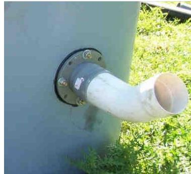
**Figura 6** – Colocación de la brida y curva
