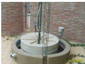
**Figura 1** Gasómetro del tipo “Campana flotante”. Imagen gentileza Orlando Giampaoli
