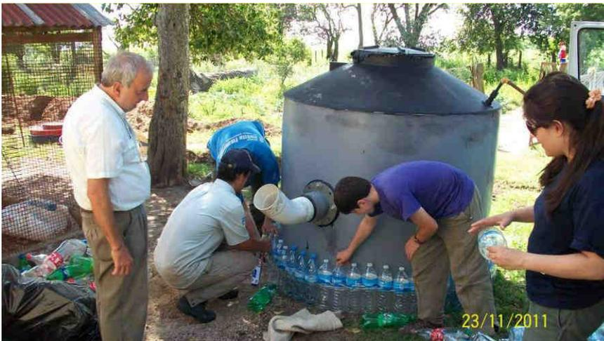
Figura 32 – Colocación de botellas plásticas como medio de aislación para el biodigestor
