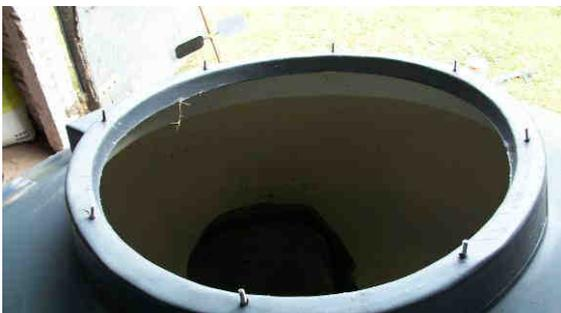
**Figura 14** – Colocación de bulones en biodigestor
