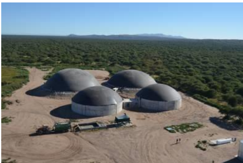
Biodigestores instalados en el establecimiento Yanquetruz en San Luis.
