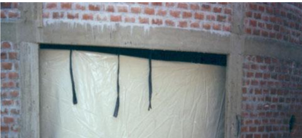
Puerta del silo mostrando la bolsa de gas
