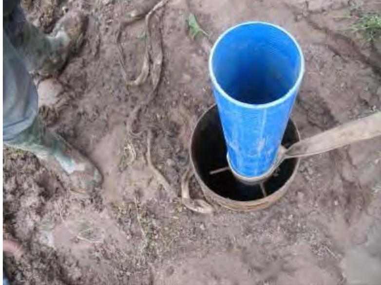
**Detalle de las guías para centrar el filtro dentro de la perforación.**
