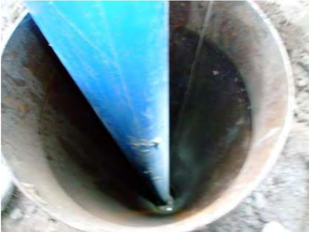
**Detalle del control de la introducción del material del prefiltro con una tanza y una pesa para que no falte grava a medida que se va extrayendo el caño camisa de 300 mm de diámetro.**
