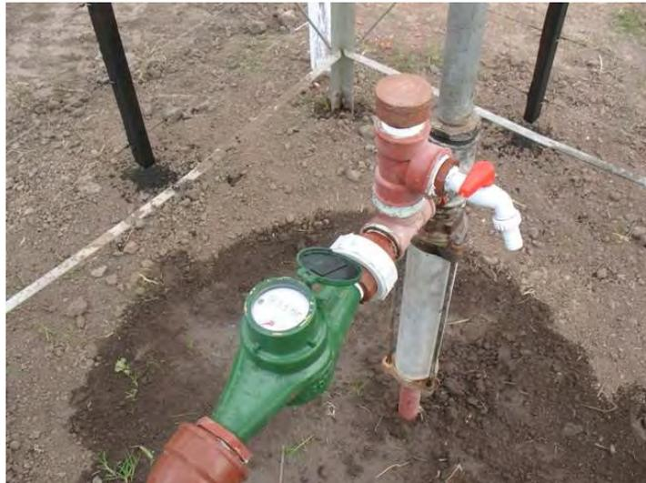
**Caudalímetro instalado en el molino para evaluar el volumen extraído en el tiempo**
