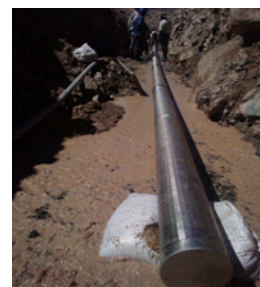
Figura 1: Filtro de acero inoxidable, de abertura 0,75 mm.
