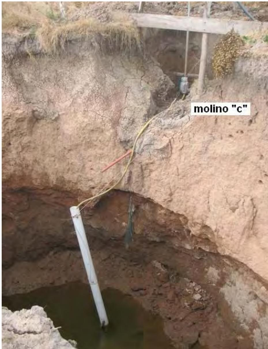
**Ubicación del molino “c” respecto a la represa de menor tamaño. El peligro de derrumbe está latente por el grado de socavamiento del talud donde está el molino**
