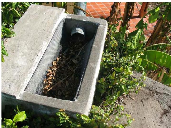
**Detalle del prefiltrado y sistema de doble decantación para que el agua entre limpia al aljibe.**
