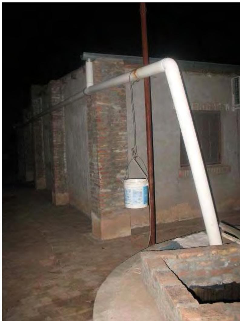
**Bajada al aljibe del agua cosechada en los techos, propiedad de Pedro Bustos. Se ve el balde de extracción y que el aljibe no tiene la tapa en el lugar. Esto no es deseable. Hay que tratar de reacondicionar la bomba de mano y tapanlo de manera permanente.**
