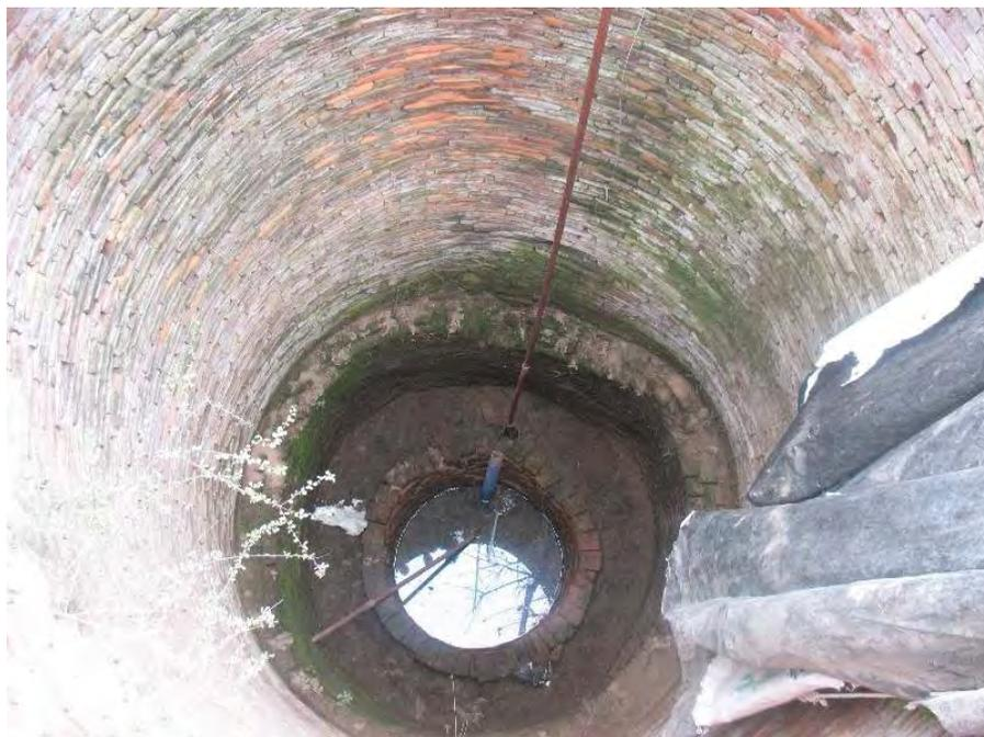
**Pozo calzado de gran diámetro con perforación interna donde succiona el molino**
