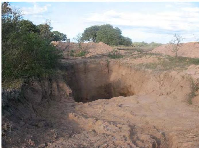
**Represa/pozo construida con retroexcavadora al lado de la perforación**
