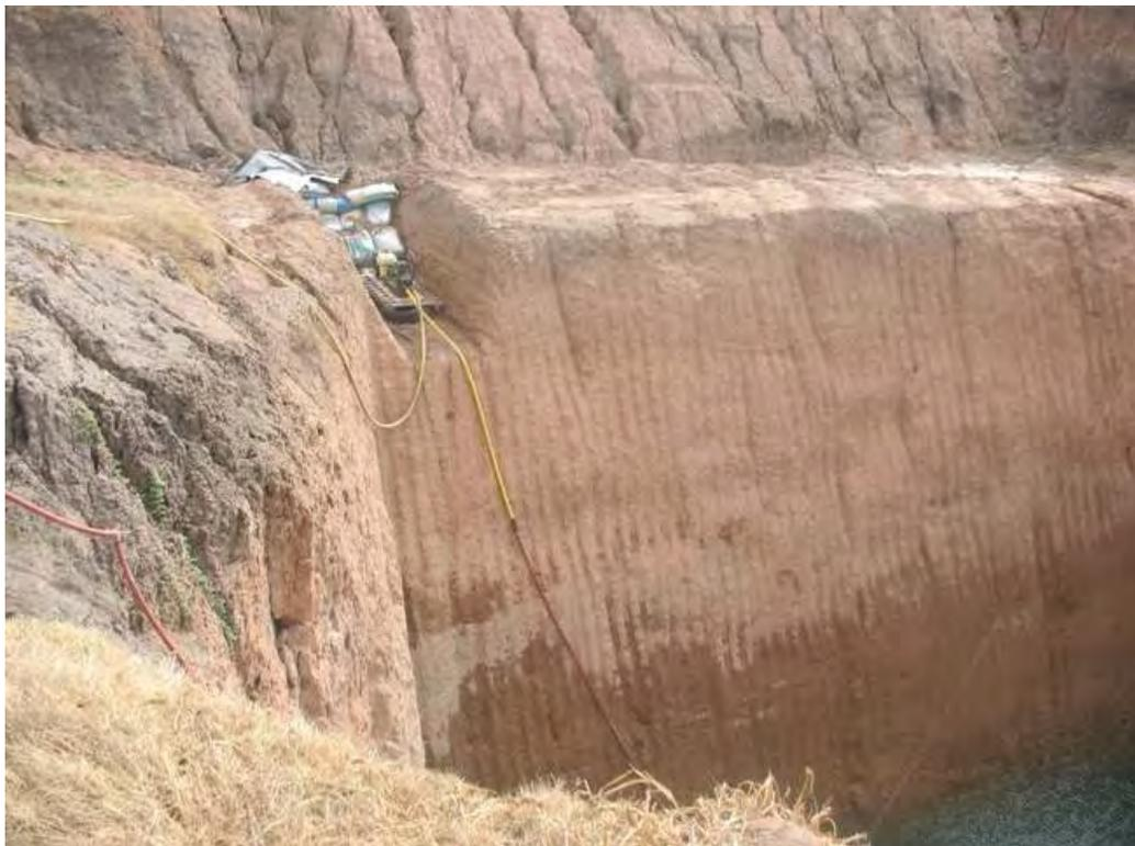
**En la represa de mayor tamaño se ha implementado una bomba de diafragma para bombear agua cuando no hay viento. Se ha excavado para que la bomba de diafragma succione correctamente**
