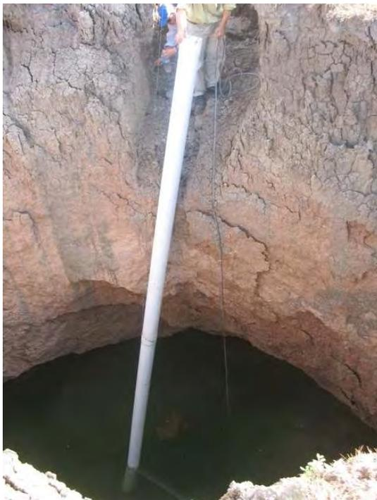
**Se observa un socavamiento importante en todo su perímetro que necesariamente hay que estabilizar. El molino debe extraer agua de superficie para obtener la mejor calidad química.**
