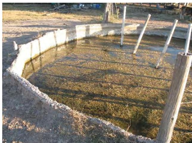
**Tanque bebedero que se debe limpiar de vegetación y analizar su reacondicionamiento**
