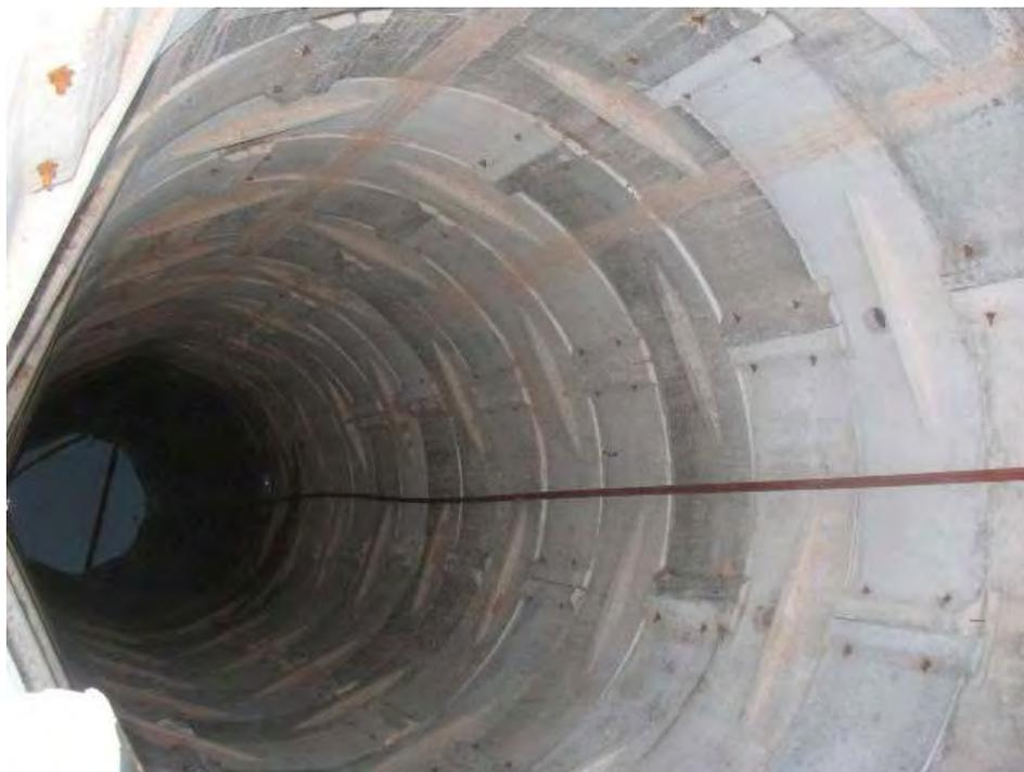
**Pozo de gran diámetro calzado con placas de hormigón armado**
