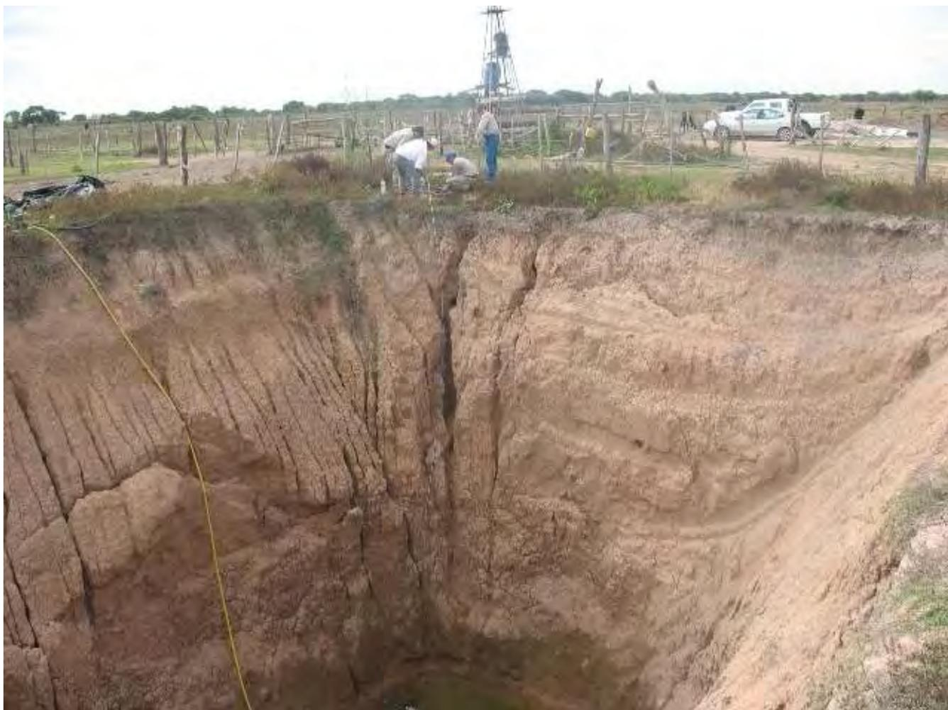
**Aguada sumamente peligrosa debido a la verticalidad de sus taludes y a su profundidad**
