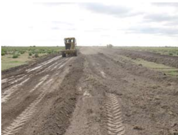
Construcción de un camino doble propósito: captación de agua de lluvia y tránsito vehicular.
