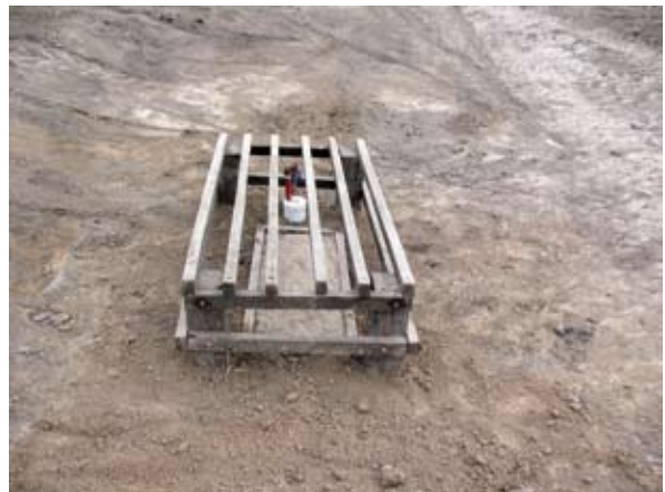
Perforación doble propósito con protección terminada.
