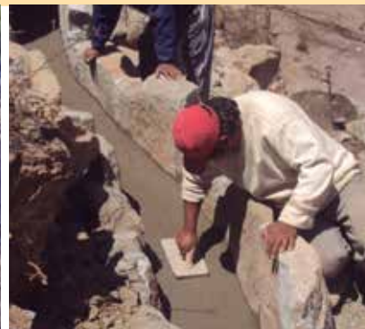
También se pueden realizar las paredes con piedra y el piso con una carpeta de hormigón.
