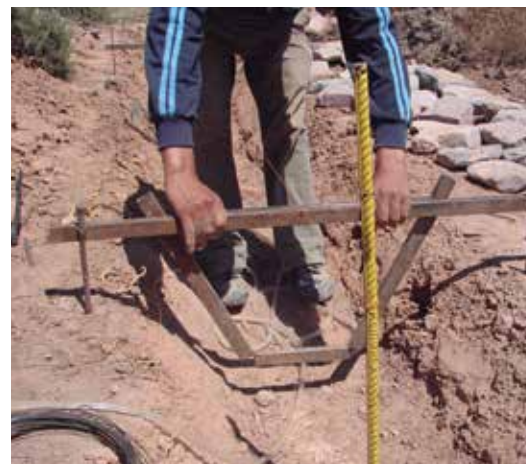
Colocación de los marcos a nivel.
