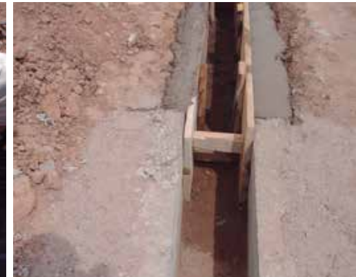
Continuamos con el encofrado y relleno de las paredes. Debemos mantener húmedo el tramo ya construido.
