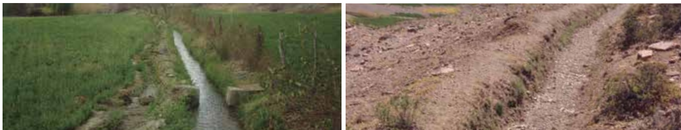
Canales sin revestir.
