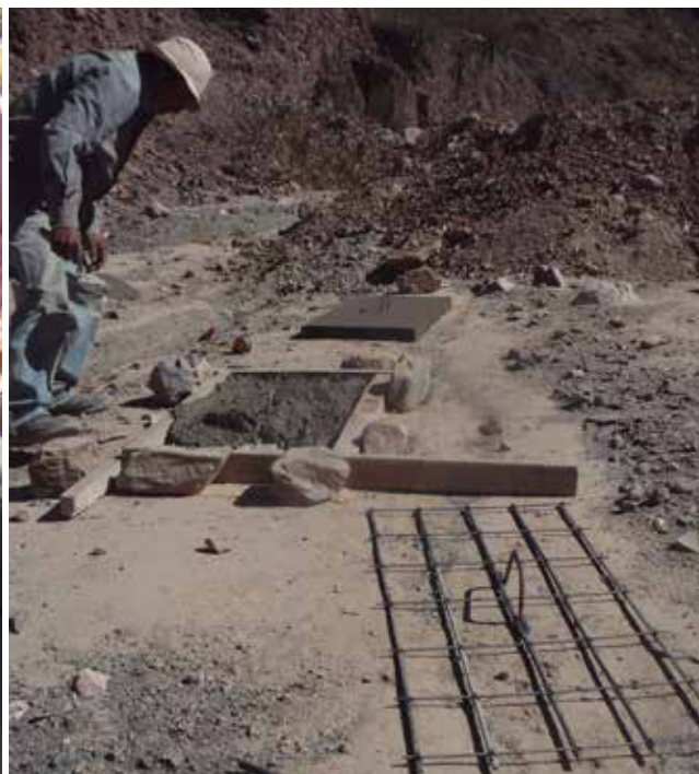
Construcción de las tapas de las cámaras. Juella y Churcal, Jujuy.
