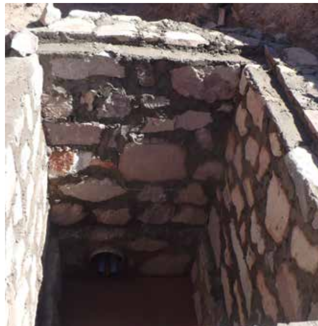
Cámara intermedia manteniendo el flujo libre (sin control de presiones). Juella, Jujuy.
