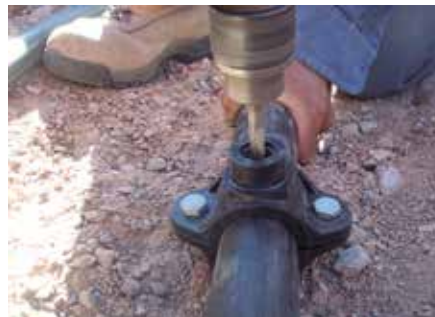
Colocación del collar de derivación.
