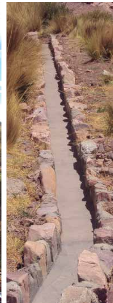
Canales rectangulares realizados con piedra y junta de cemento.
