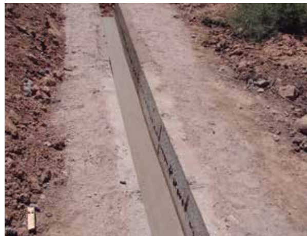
Realizamos el piso del canal. Tenemos que dejar espacio para las juntas.
