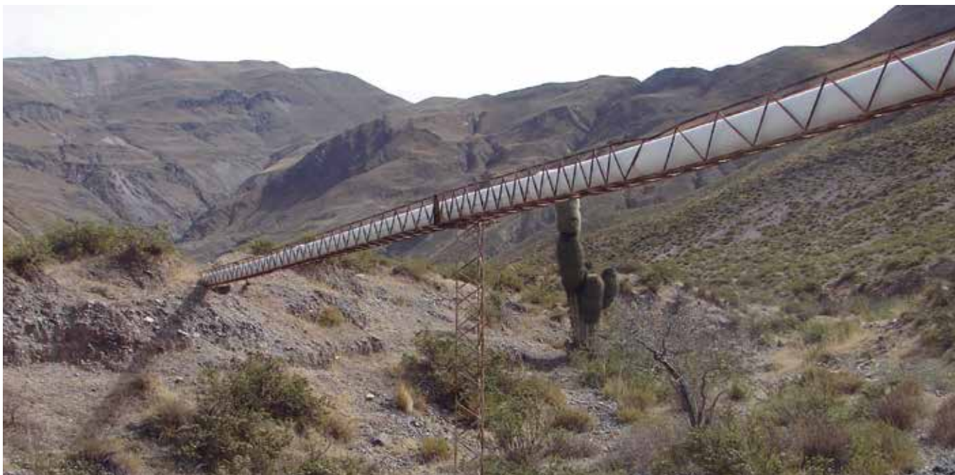
Paso de la tubería en una quebrada mediante estructura de hierro. Comunidad Finca Tumbaya, Jujuy.
