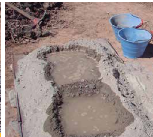
Preparación del hormigón.
