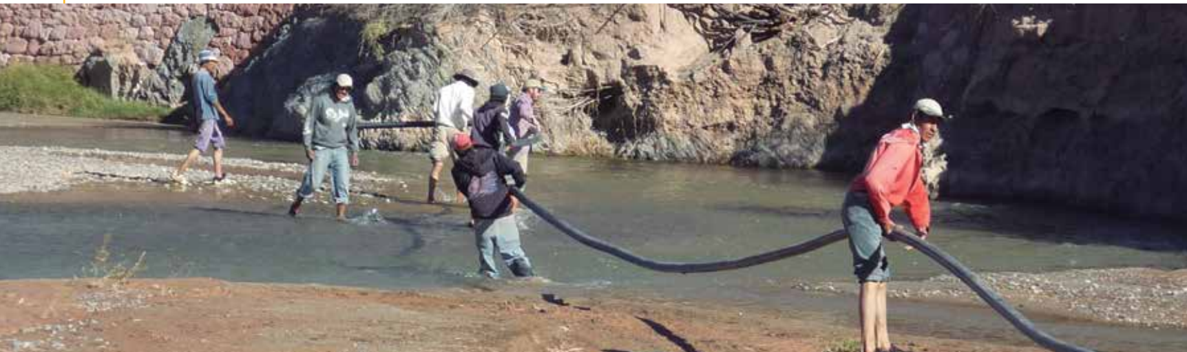
Instalación de tuberías. Comunidad El Churcal, Salta.
