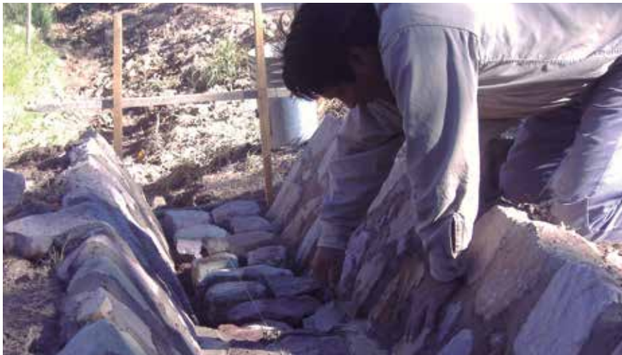
Canal con talud inclinado o sección trapezoidal.
