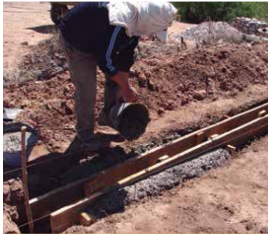
Volcado del hormigón.
