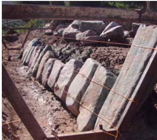
Calzado de las piedras con junta de cemento. Se observan los hilos que limitan la sección del canal, las piedras se colocan por fuera de los hilos.
