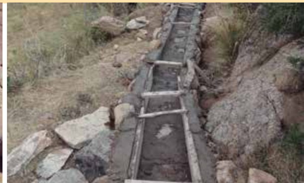
También se pueden realizar las paredes con piedra y el piso con una carpeta de hormigón.
