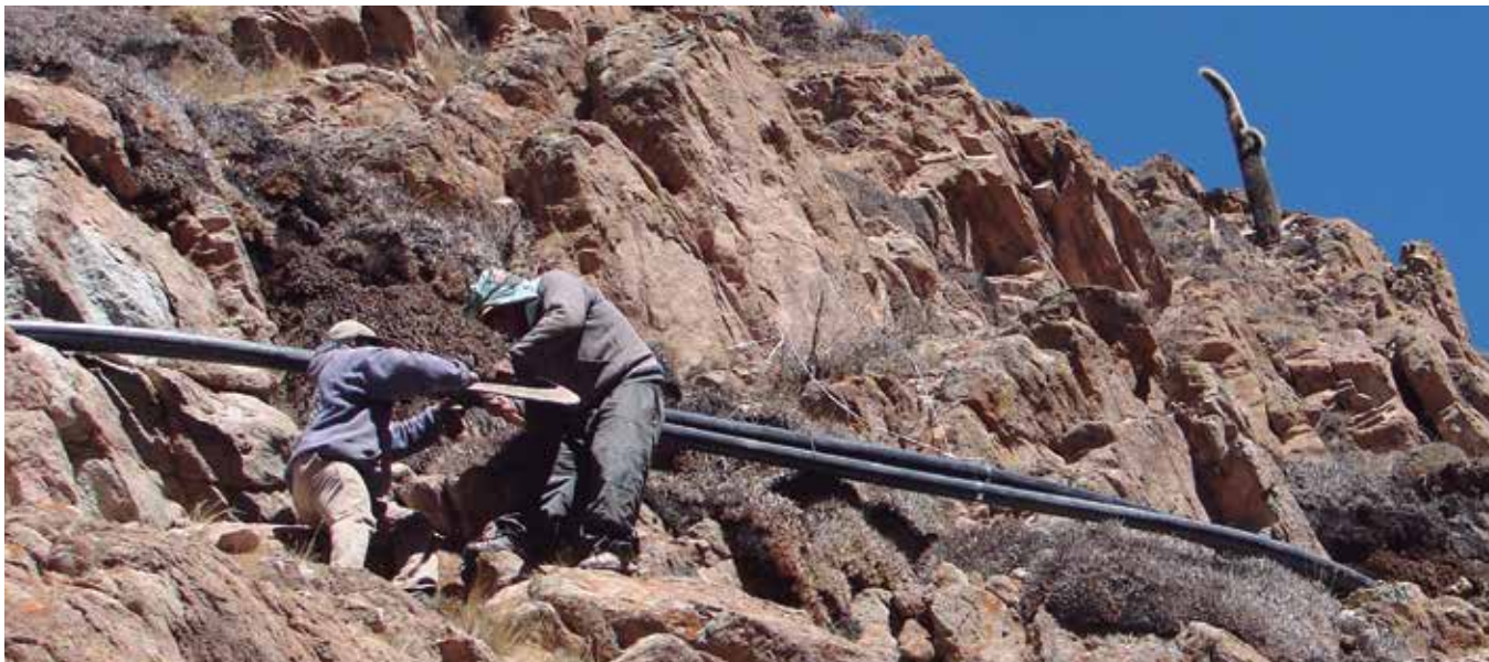
Tuberías colocadas en terrenos rocosos. Huachichocana, Jujuy.
