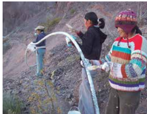
Pintar con pintura blanca la tubería o bien la media sombra, aumenta la duración de los materiales ante la exposición al sol. Comunidad Maymaras, Jujuy.
