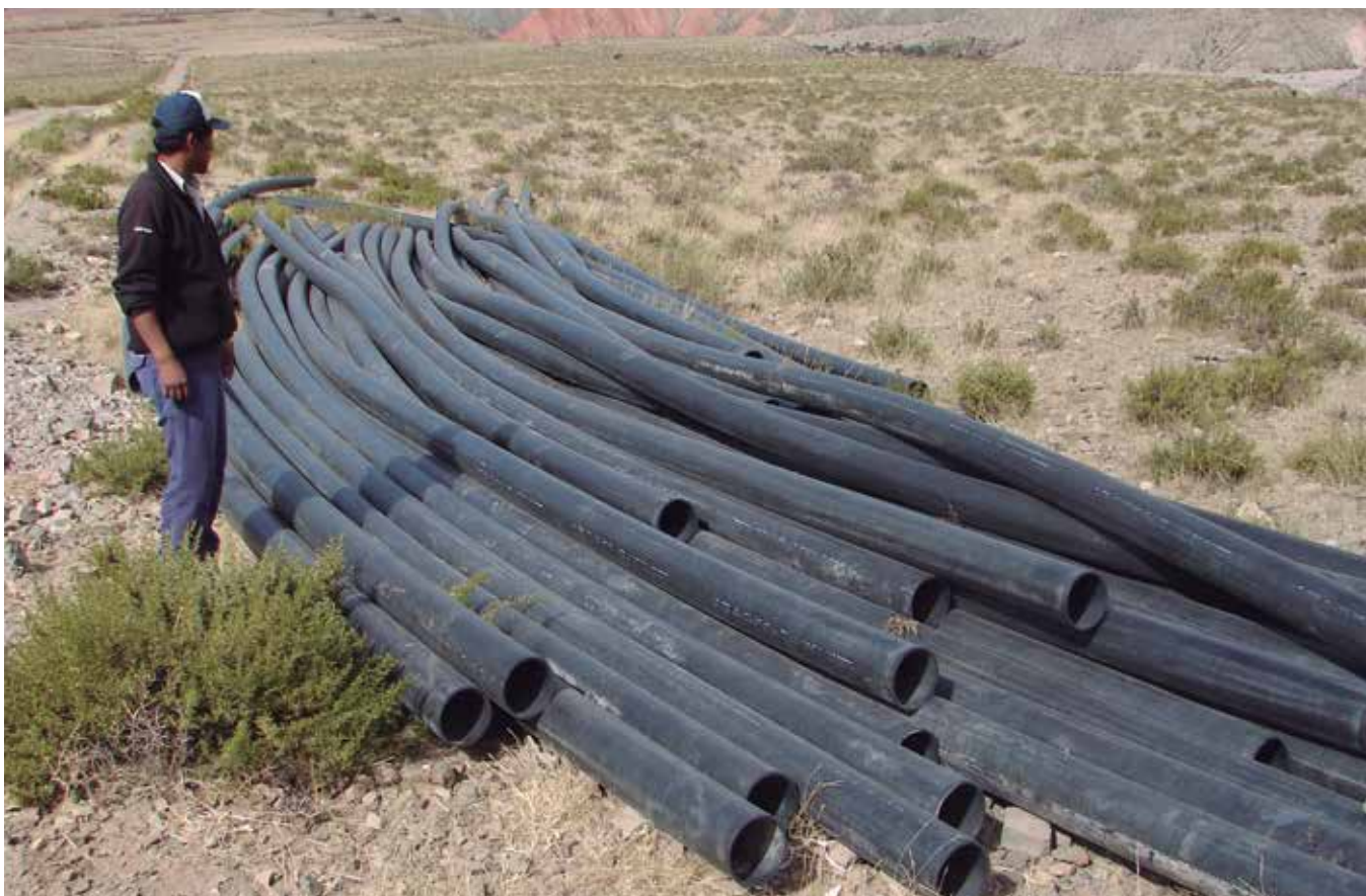
Tubería de polietileno tipo PEAD de 160mm y 18m de longitud. Comunidad Finca Tumbaya, Jujuy.
