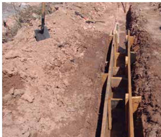
Armado y humedecimiento del encofrado.
