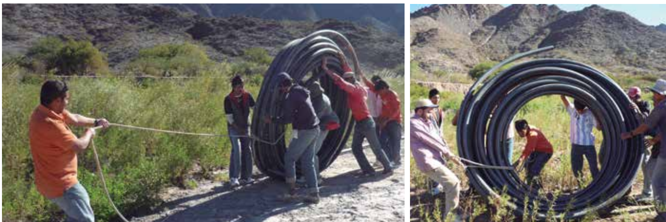
Desenrollado mediante una sog para evitar la formación de espirales que produzcan quiebres en la tubería. Comunidad El Churcal, Salta.
