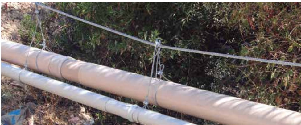
Pendolones en puente colgante.
