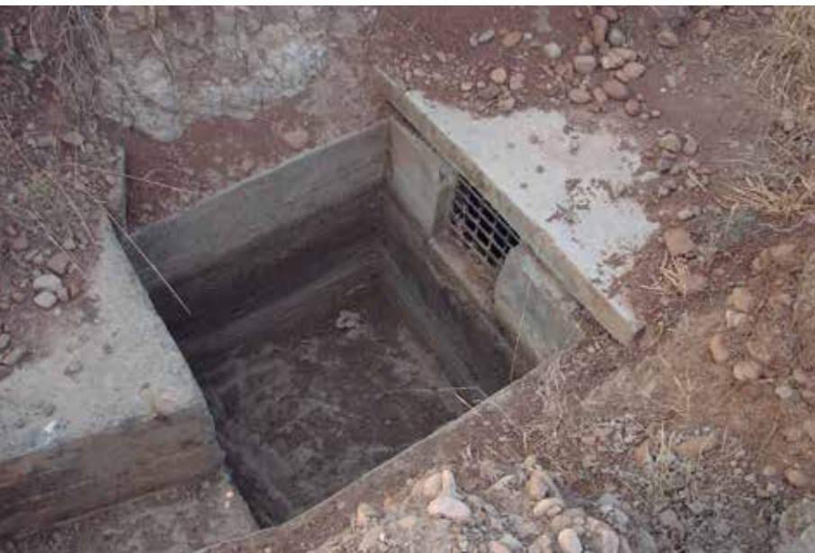
Cajero de entrada a un puente mediante tuberías.
