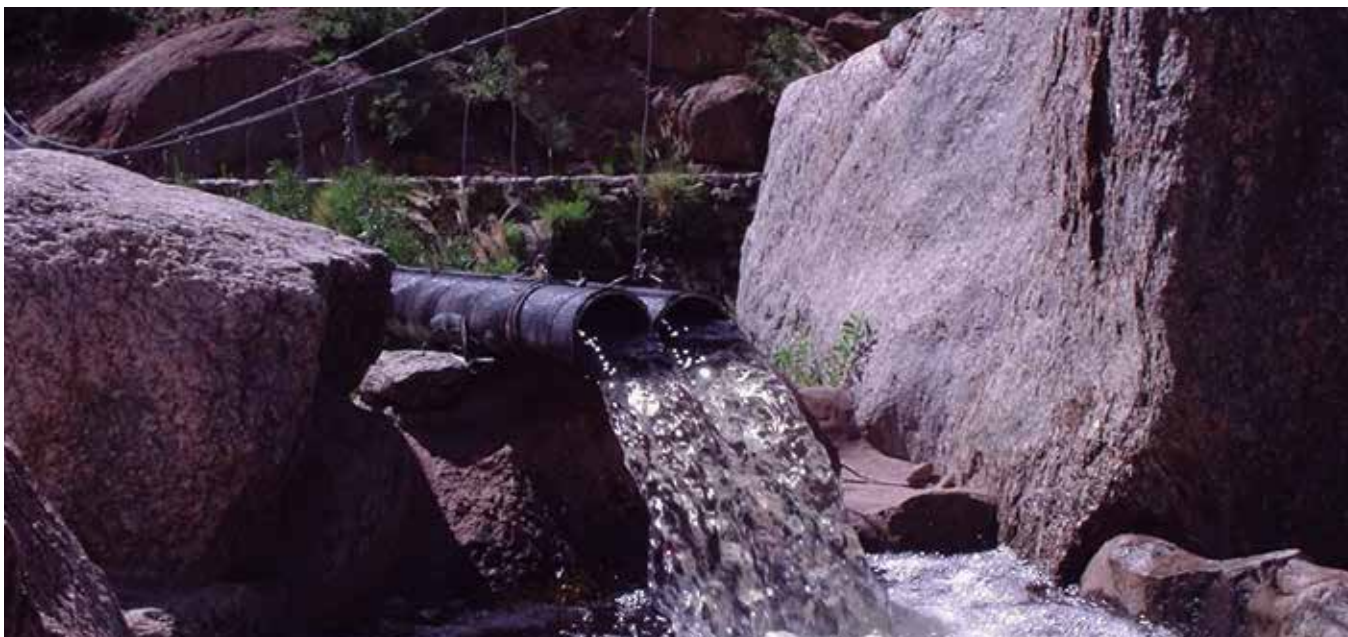
Puente colgante realizado en un sistema de conducción mediante canales. Comunidad Refugio, Salta.
