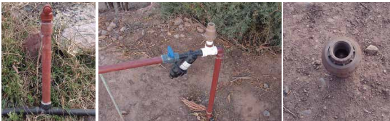
Válvula de purga o de aire. Las válvulas automáticas cuentan con una esfera interna que ante la falta de presión se abren permitiendo la expulsión del aire.
