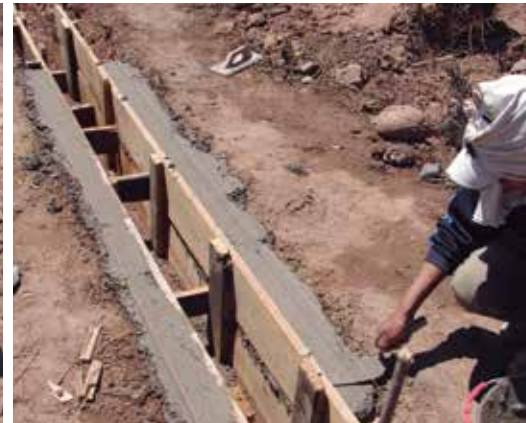
Terminación de las paredes. Se observan las trabas que sostienen las tablas.
