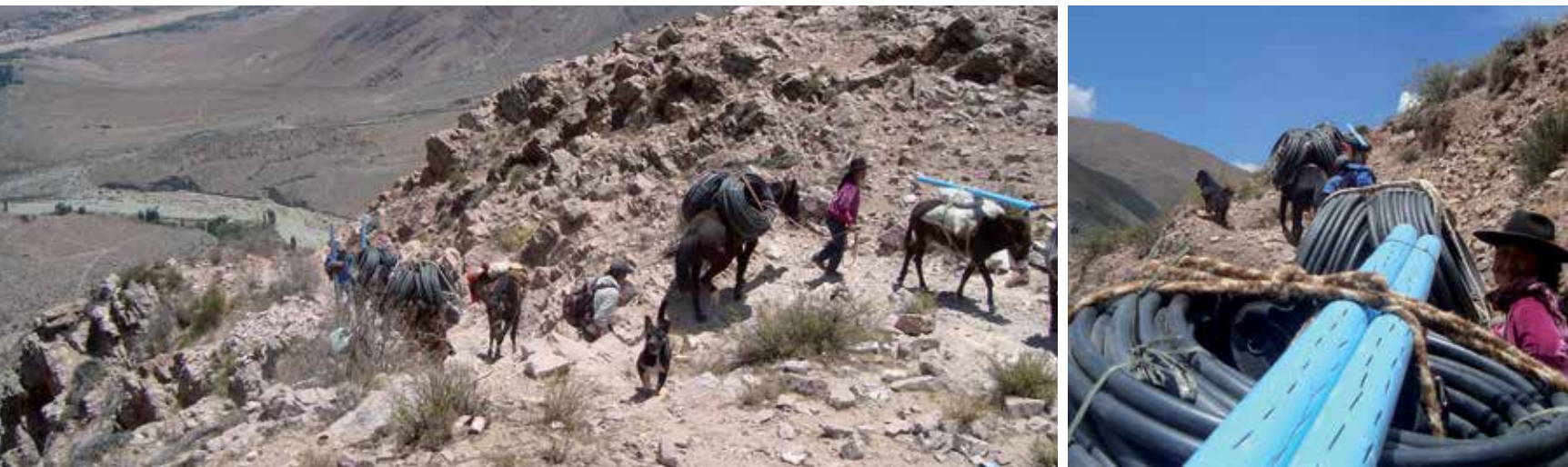
Transporte de materiales para Proyectos de Abastecimiento de Agua en Comunidades de los Valles Orientales de Tilcara, Jujuy.
