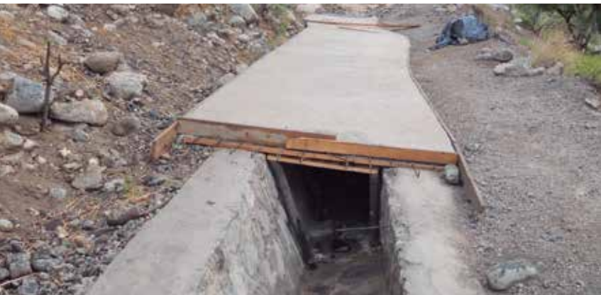
Para proteger al canal de las piedras que caen se construyó una tapa de hormigón. Comunidad San Antonio, Salta.
