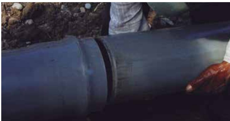
Tubería con extremos ‘macho’ y ‘hembra’.
