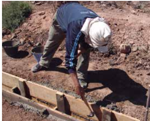
Hacemos que el hormigón rellene bien mediante golpes o removiendo con una varilla.
