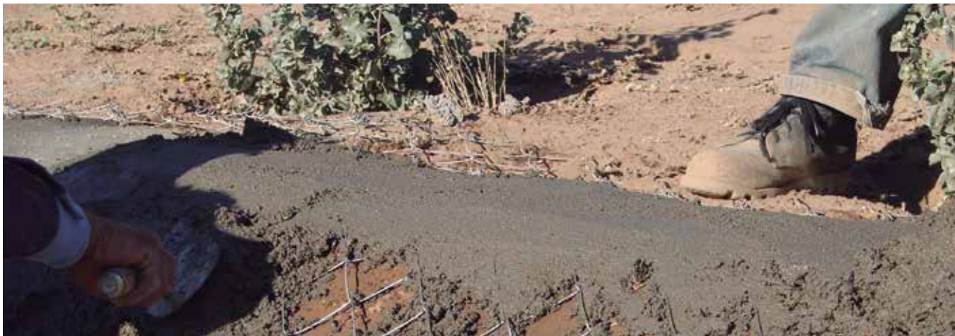
Revestimiento con ferrocemento.
