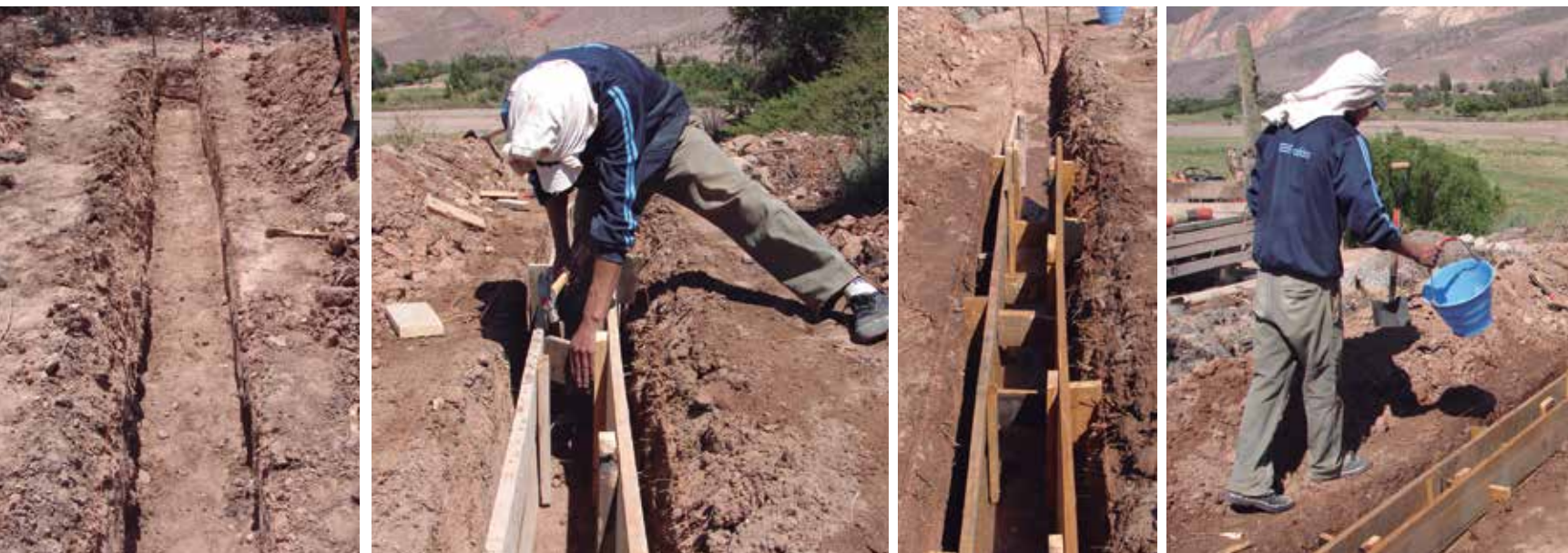
Encofrado de la excavación.
