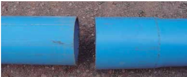
Unión de tuberías mediante adhesivos.
