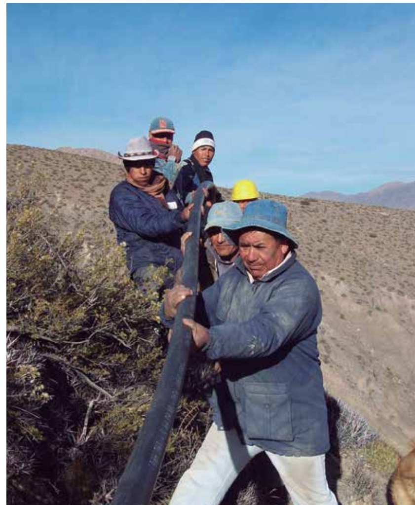
Instalación de tuberías. Comunidad Punta Corral, Jujuy.
