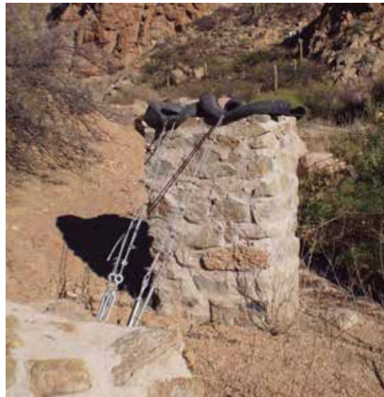
Columnas realizadas en mampostería.
