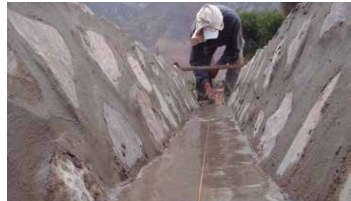
Construcción del piso. El hilo nos marca el nivel. En este caso el piso se hizo de hormigón simple, pero también se puede realizar con piedras.
