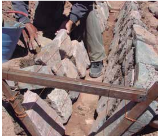
Calzado de las piedras con junta de cemento. Se observan los hilos que limitan la sección del canal, las piedras se colocan por fuera de los hilos.
