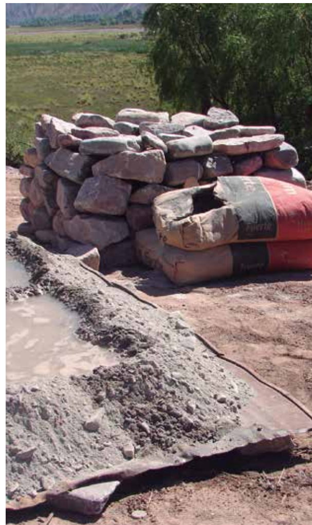
Preparación del concreto o mortero.
