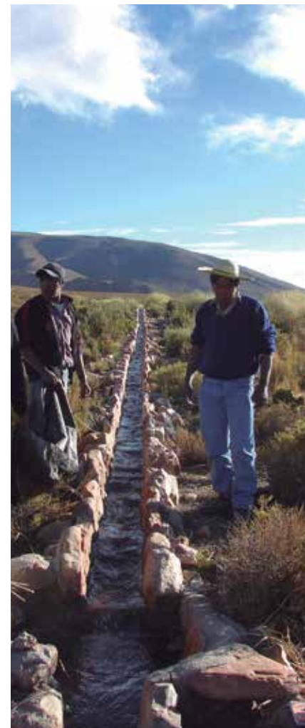
Canales rectangulares realizados con piedra y junta de cemento.
