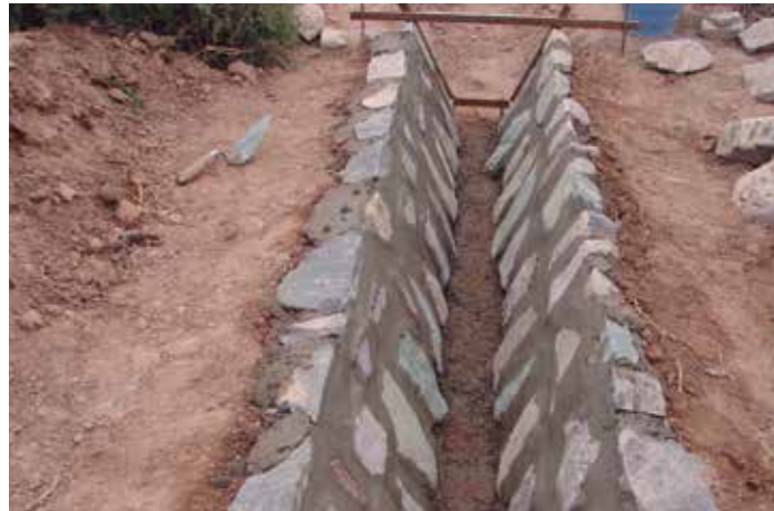
Construcción del piso. El hilo nos marca el nivel. En este caso el piso se hizo de hormigón simple, pero también se puede realizar con piedras.
