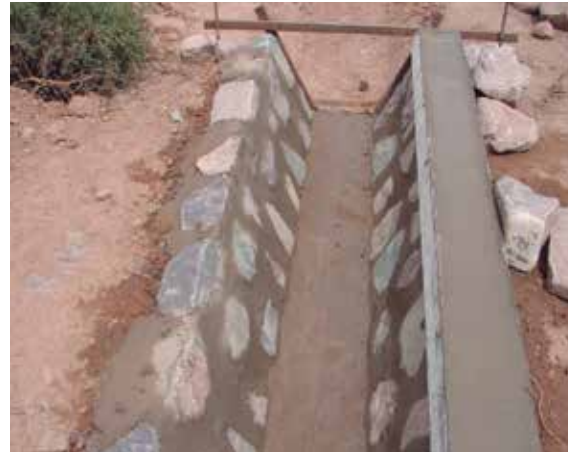
Terminación del tramo de canal.
