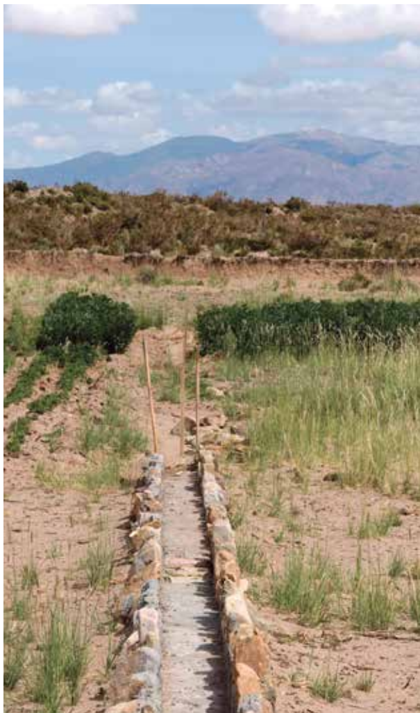
Impermeabilización de acequias mediante piedra calzada y junta de cemento.
