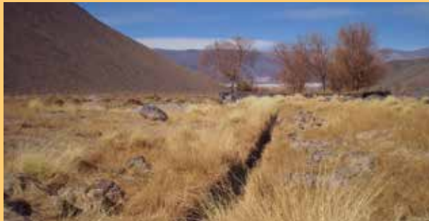
Conducción a 'flujo libre' mediante canales.
