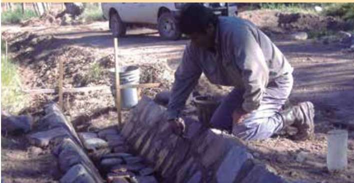
En canales trapezoidales por sus taludes inclinados el uso de piedra facilita la construcción.
