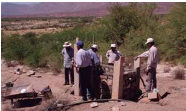
Las cámaras rompecargas se pueden realizar sobreelevadas o enterradas.
