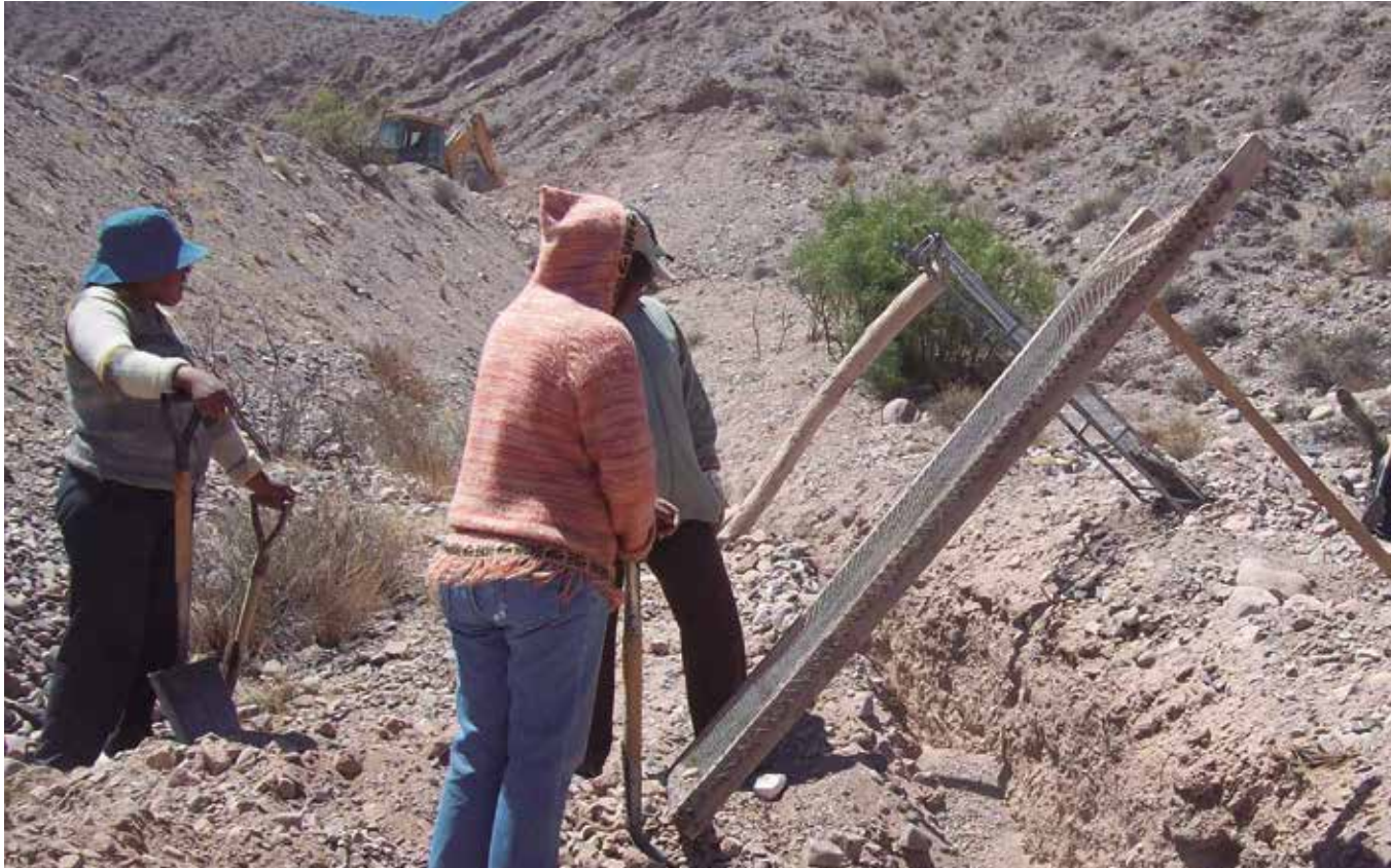
Zarandeo de tierra previo a la instalación de la tubería. Comunidad Maymaras, Jujuy.
