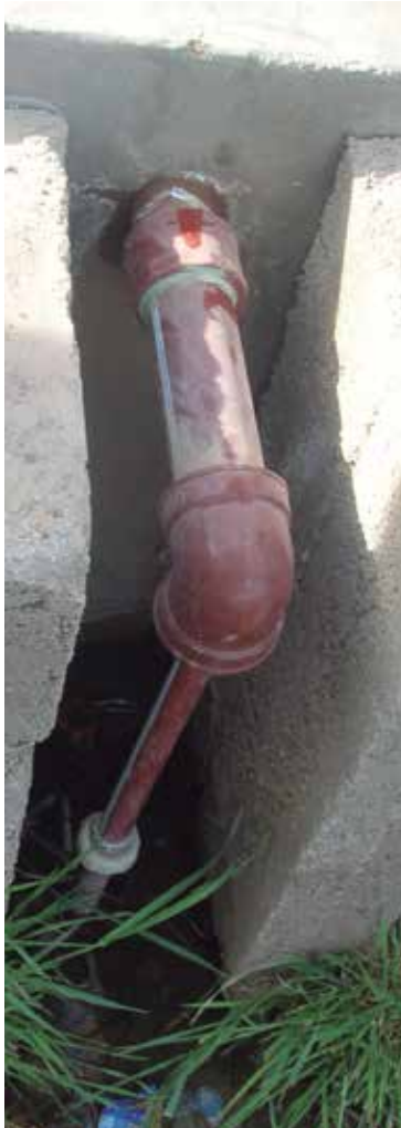
Tubería con caños de polipropileno en tanques intermedios.
