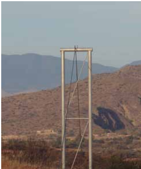
Columnas realizadas con tubos galvanizados.
