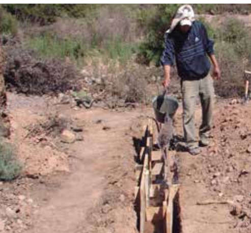
Armado y humedecimiento del encofrado.
