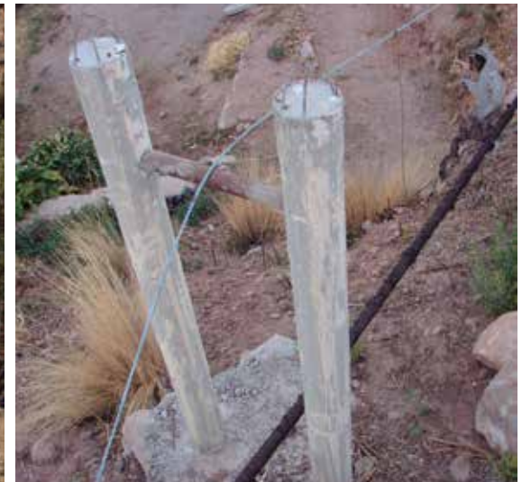
Columnas de hormigón armado realizadas mediante encofrado con caños de PVC (internamente tiene hierro y relleno de hormigón).
