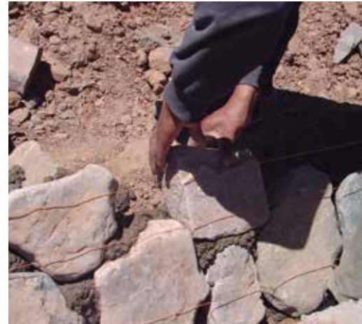
Calzado de las piedras con junta de cemento. Se observan los hilos que limitan la sección del canal, las piedras se colocan por fuera de los hilos.
