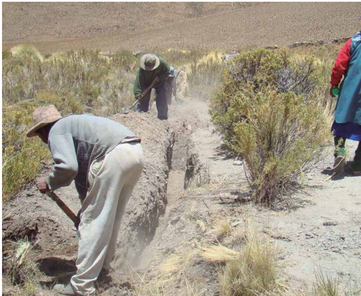
Excavación en Comunidad Urcuro, Salta.
