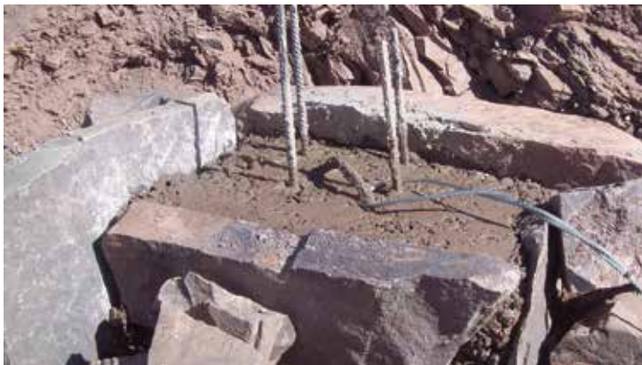
Construcción de anclaje para puente simple. Comunidad Maymaras, Jujuy.
