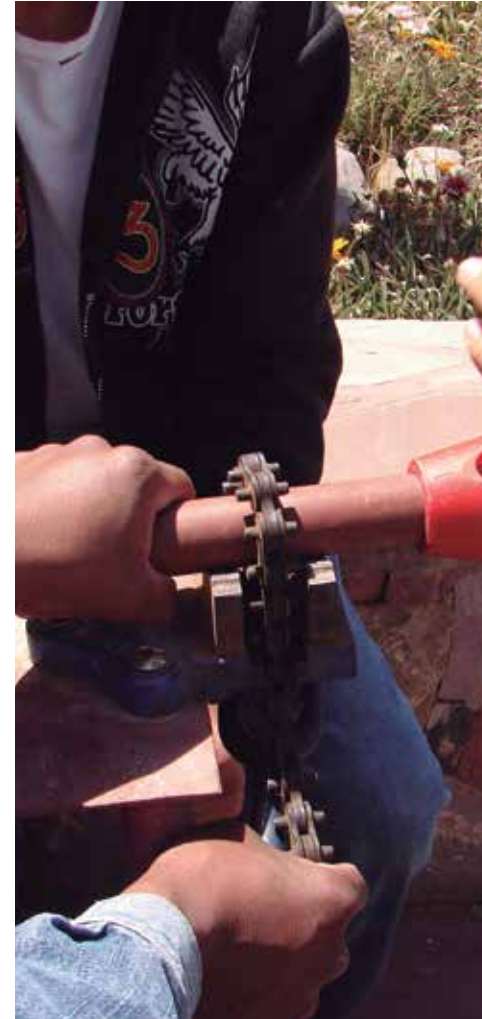
Realización de las roscas con terraja.
