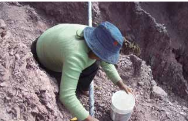
Pintar con pintura blanca la tubería o bien la media sombra, aumenta la duración de los materiales ante la exposición al sol. Comunidad Maymaras, Jujuy.
