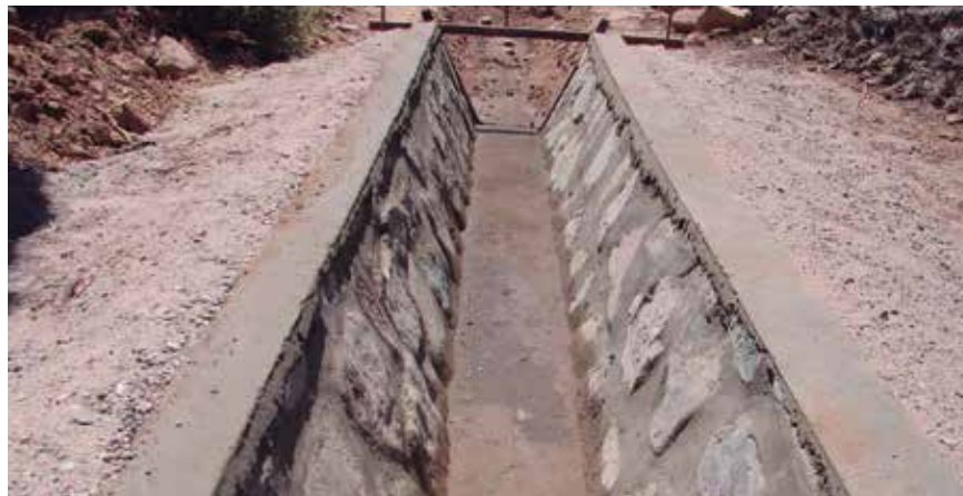
Terminación del coronamiento del canal.
