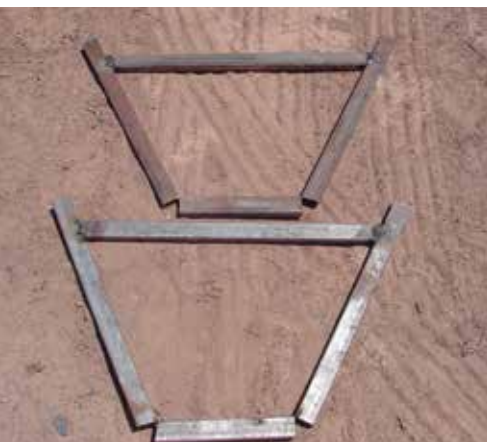
Marcos para la construcción de canales trapezoidales.
