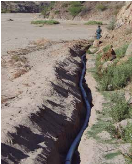
Colocación de tubería en forma ondulada sobre cama de tierra. Tomuco, Salta.
