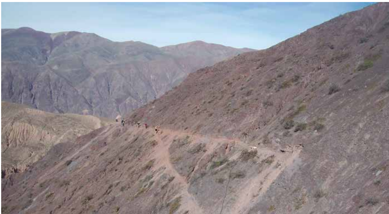
Instalación de tubería en ladera. Comunidad Maymaras, Jujuy.
