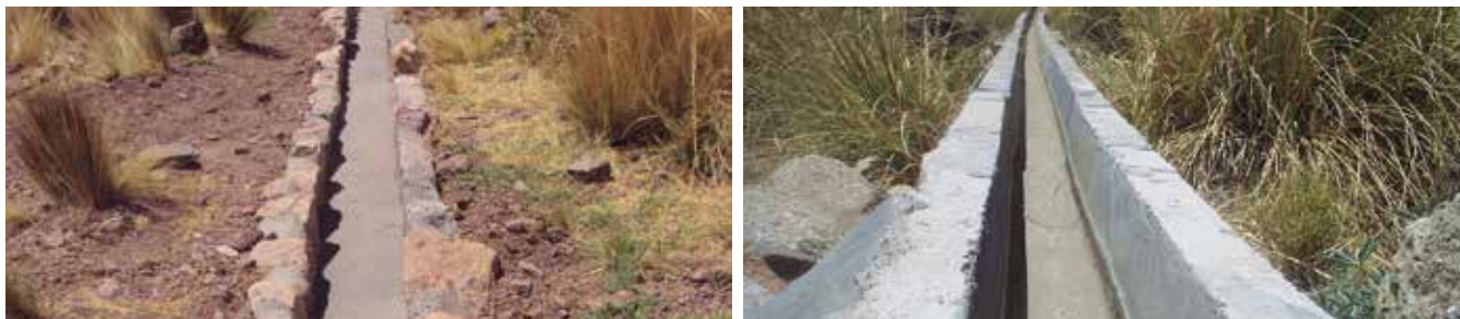
Canales revestidos en piedra calzada con junta de cemento y hormigón
