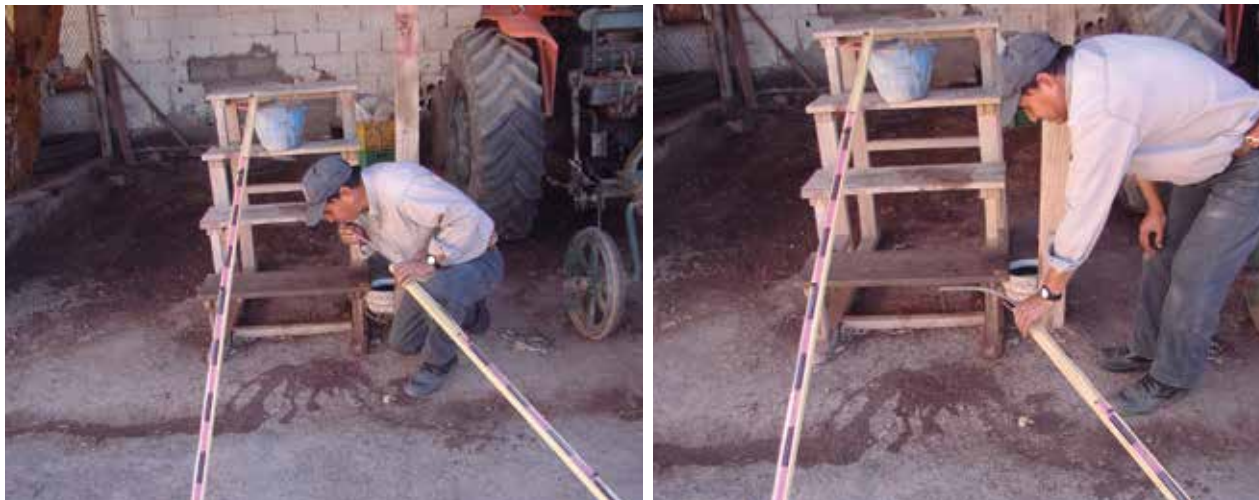
Llenado de la manguera con agua.
