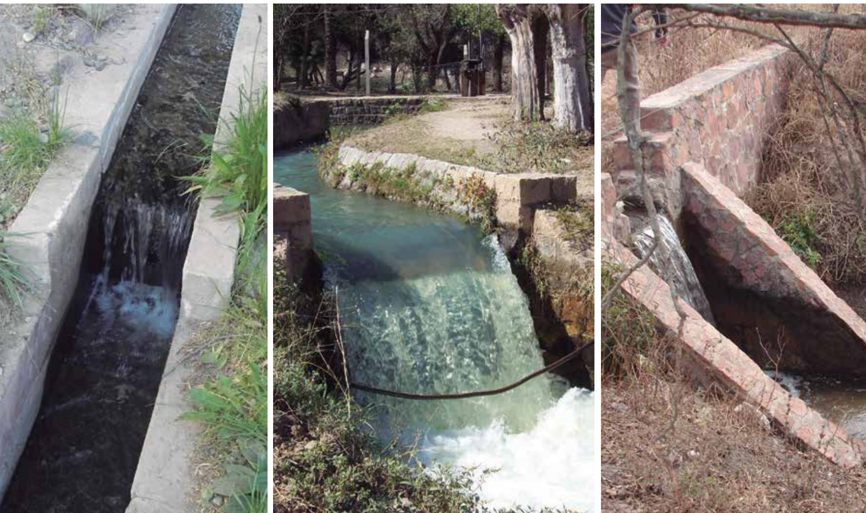
Mediante saltos podemos resolver cambios en la pendiente o mantener la pendiente de diseño.
