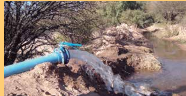
Sistema a presión mediante tuberías.
