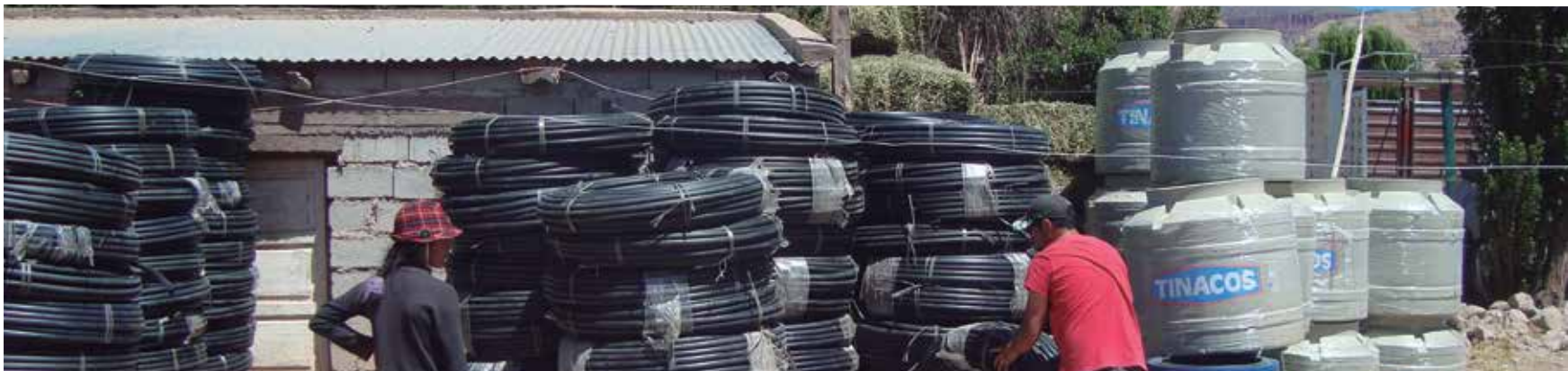
Acopio de tuberías.
