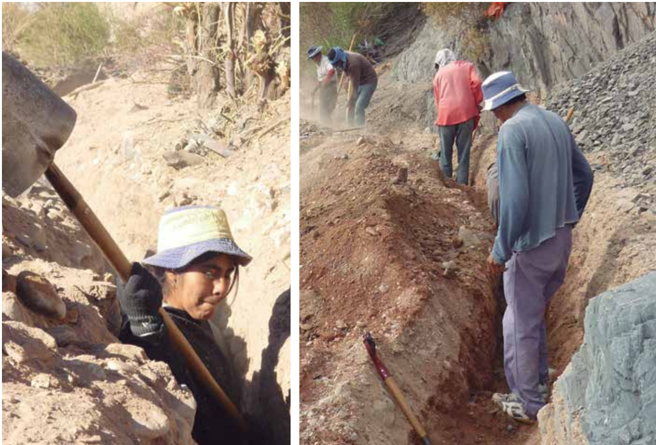
Excavación para la instalación de tuberías. Comunidad El Churcal, Salta.
