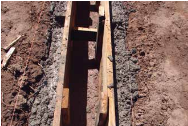
Canal de hormigón con taludes verticales.
