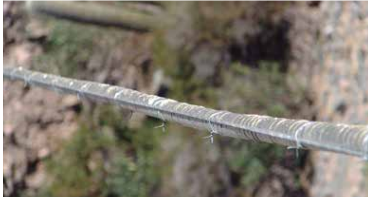
Protección de la tubería con tela media sombra y membrana asfáltica.
