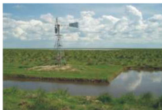
Perforación Sistema Araña y Represa de Recarga (Fotografía ALP)
