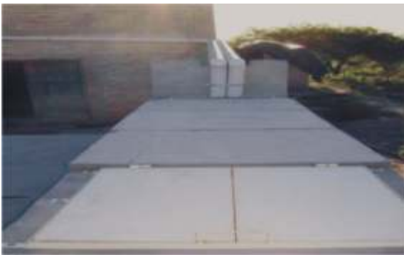
Filtro de arena y piedra
