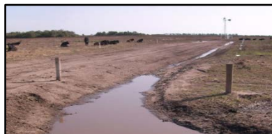
Figura 7- Sistematización del camino de acceso doble propósito.
