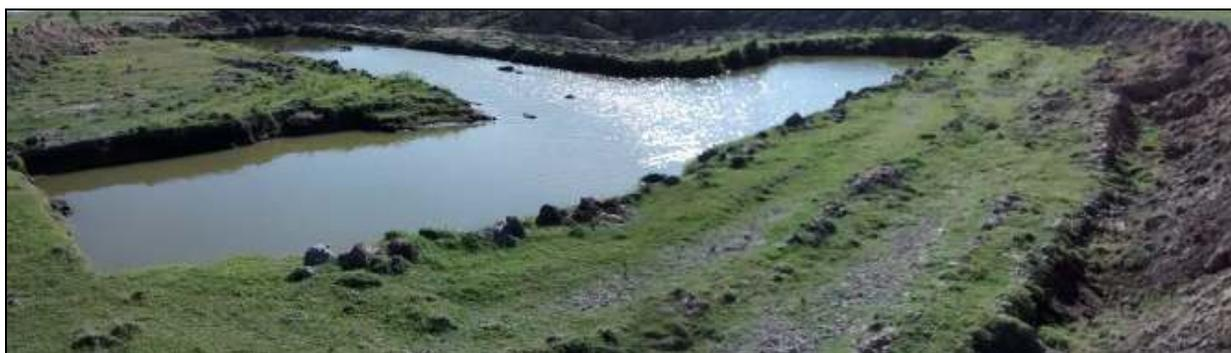
**Fotografía del jagüel interior, y el principio de construcción de las paredes del tanque de tierra implementándose, la cual debe perfeccionarse. La CE del agua del jagüel = 4 dS/m.**
