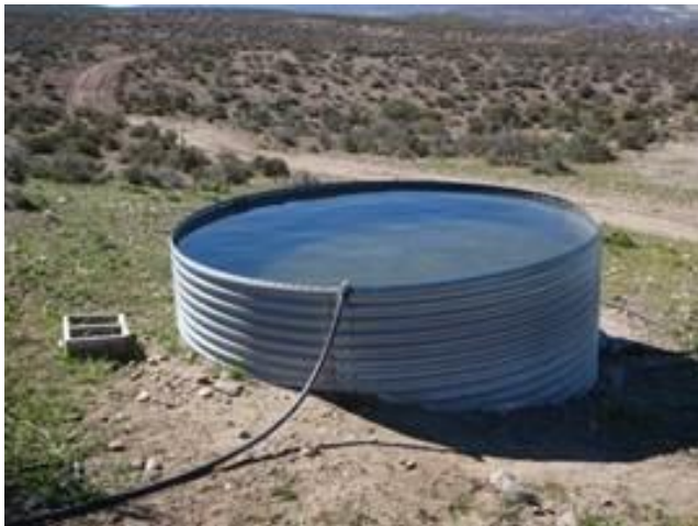
Foto 9. Vista del tanque australiano almacenando el agua de la conducción.
