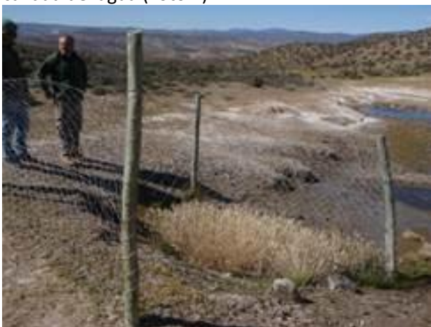
Foto 7. Cerco perimetral protegiendo obra de captación, de animales, pisoteo y contaminación. Vegetación herbácea crecida sobre la misma.
