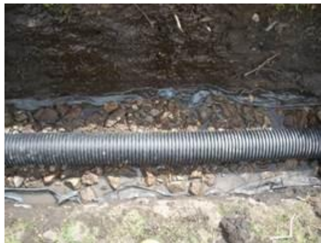
Foto 3 Caño ranurado apoyado sobre una base de geotextil y piedras.
