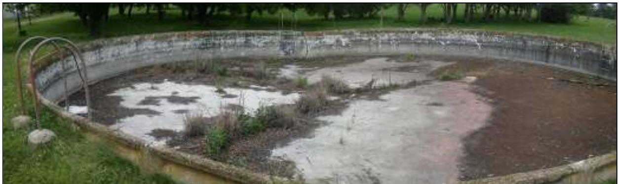
**Tanque australiano con posibilidades de rehabilitarse para almacenar agua de lluvia de la Planta de Semillas.**
