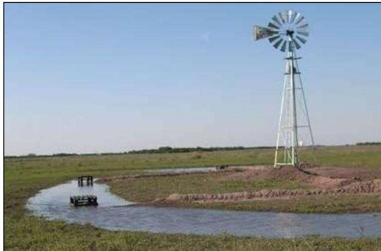
**Fig. 3- Sistematización del terreno con un canal en forma de plato para inducir el agua de las lluvias a cada uno de los puntos de recarga.**
