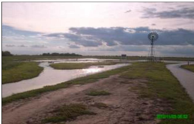
**Fig. 4- Sistematización del camino de acceso de doble propósito: tránsito y “cosecha” de agua de lluvia.**
