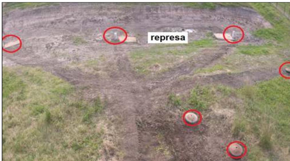
Fig. 7- Disposición actual de las 3 perforaciones doble propósito dentro de la represa con chupadores flotantes más las 3 perforaciones convencionales que conforman el sistema “patas de araña” del Sistema B.
