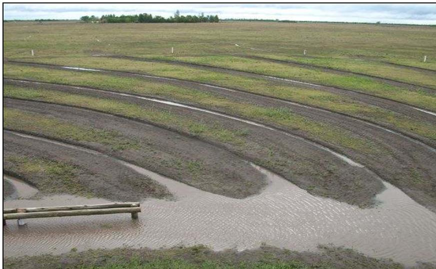
**Fig. 10-** Área de captación actual del Sistema C compuesto por colectoras radiales helicoidales. Diseño: Lahitte, A.
