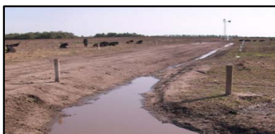
Figura7- Sistematización del camino de acceso doble propósito.
