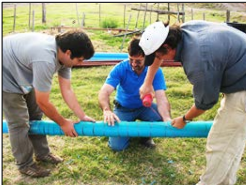
Foto 2: Construcción de un filtro artesanal
