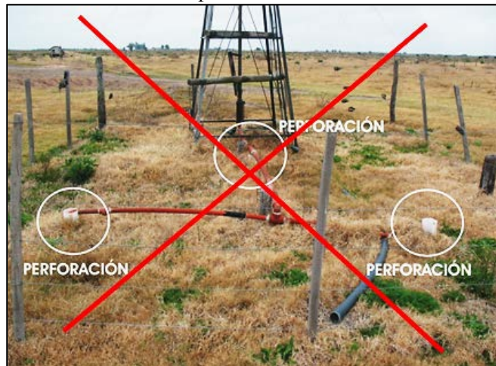
Foto 9: Sistema con perforaciones demasiado cercanas.
