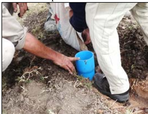
Foto 3: Implementación del prefiltro con materiales acordes al acuífero
