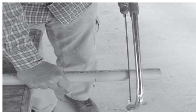
Foto 1. Ranurado del freatímetro en la zona del filtro.
