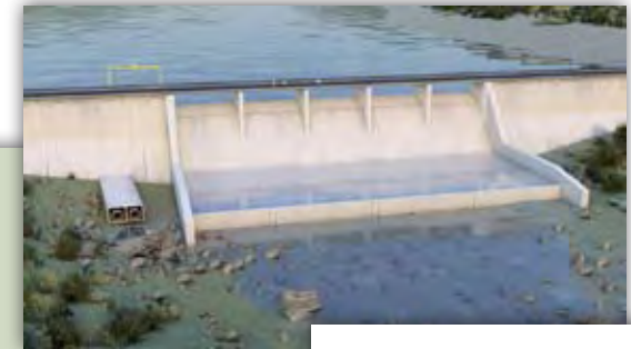
FIGURA 23 OBRA DE TOMA SOBRE EL RÍO QUINTO.
