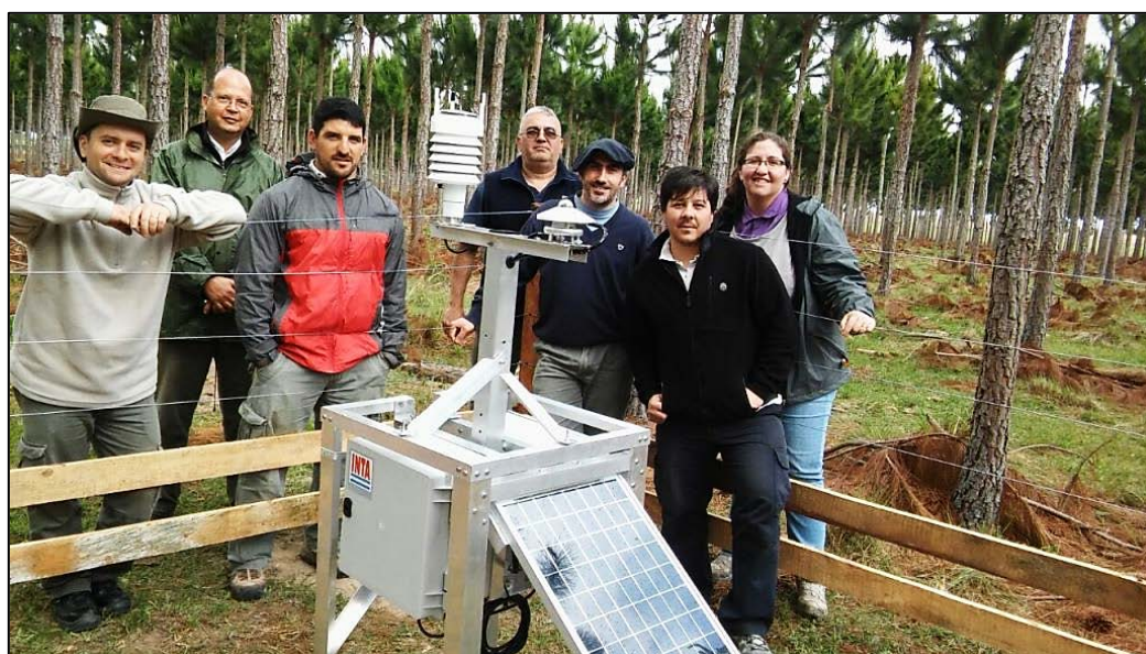
Equipo de trabajo de la instalación de la primer NIMBUS III instalada en la localidad de Concepción-Corrientes (Ariel Serritella, Martin Padin, Luis Vallejos, Franco Rosso, Diego Ybarra, Guillermo Perrens y Tania Rey Montoya). NIMBUS III Concepción-Corrientes.
