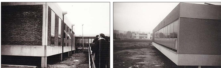
INTA Castelar. Los laboratorios en construcción. En a) alumnos recorriendo las futuras instalaciones.
