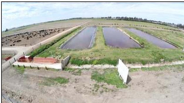
Se maduran y estabilizan los efluentes en tres grandes piletas.
