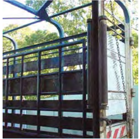
Figura 23: Rodillos funcionales colocados sobre el borde interno y externo de la puerta guillotina.
