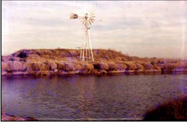
Figura 14.- Jagüel, molino y tanque australiano.
