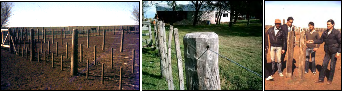
a)-Corral con alambrado de 10 hilos lisos, varillas en tres tramos para evitar roturas y postes con punta escofinada para evitar lesiones en los animales. b)- poste punta escofinada. c)-Palenque con doble corredera de caño a la salida de un brete para sujetar animales embozalados o enlazados que se saquen del brete.
