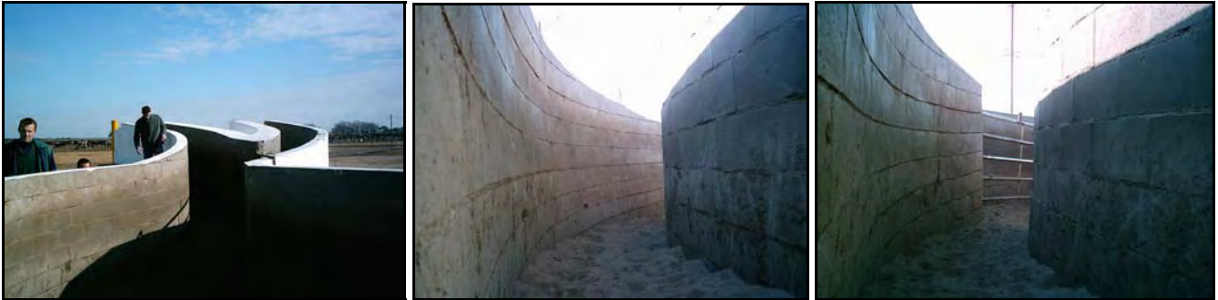
Brete cargador de cemento para atraque de dos camiones con paredes ciegas, curvas y de altura suficiente para animales con sangre cebú, piso con arena (Feedlot de Cactus Argentina S.A., Villa Mercedes, San Luis)
