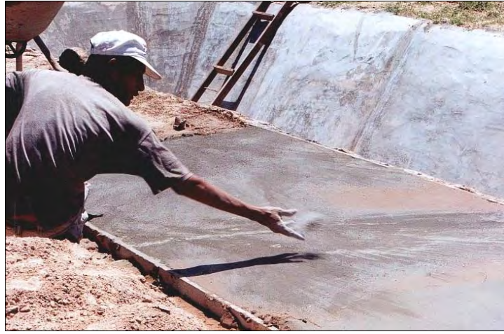
Espolvoreo con cemento para terminación final
