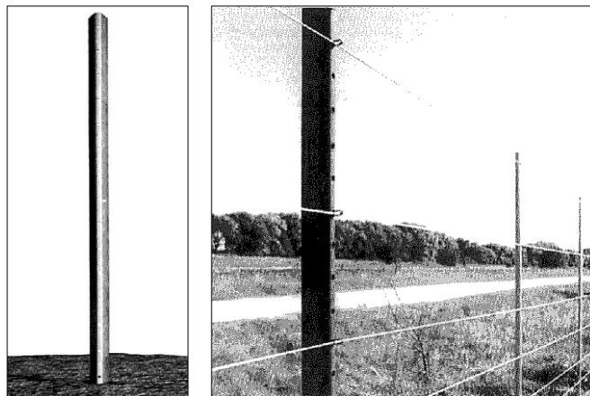
a) Poste de acero; b) alambrado con postes de acero
