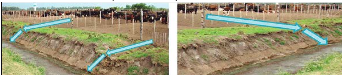
Recepción de efluentes por canales colectores.
