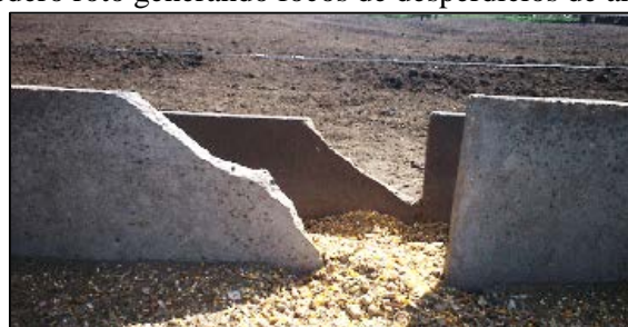
Comedero roto generando focos de desperdicios de alimento
