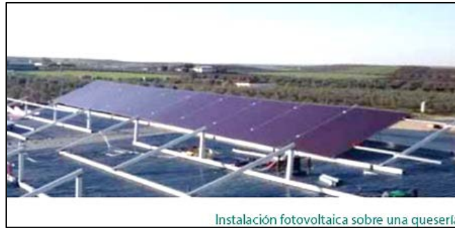
Instalación fotovoltaica sobre una quesería
