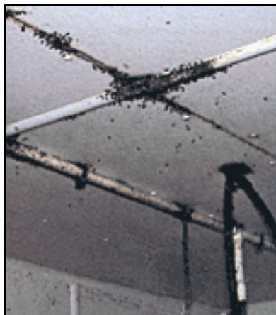
Moscas domésticas posadas en un techo. Obsérvese el moteado dejado por las moscas y su preferencia por posarse sobre tuberías a lo largo de los bordes de rendijas.
