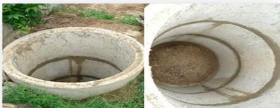
Fig. 3. Fosa de fermentación para cadáveres. (Fuente: Jacho López, 2010.)
