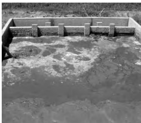
● Foto 6. Decantador de sólidos.
