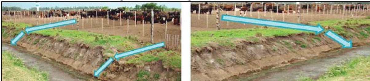
Recepción de efluentes por canales colectores.
