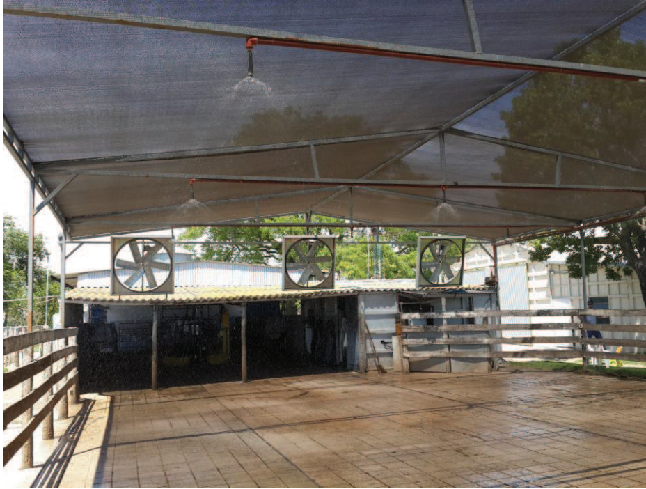
Sistema de ventilación y aspersión de Tambo Roca
