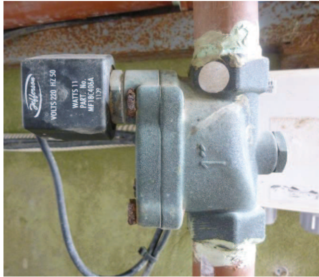
Válvula solenoide de 2 vías
