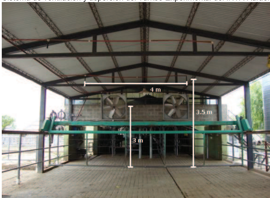
Sistema de ventilación y aspersión del Tambo Experimental del INTA Rafaela
