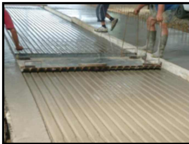
Figura 29. Ranurado paralelo en hormigón fresco utilizando molde metálico. En este caso, el diseño es de 10 cm entre línea, 2,0 cm de ancho y 1,0 cm de profundidad. (Foto Azienda Agricola ZAMBIANCHI).
