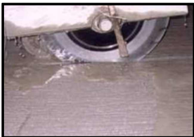
Figura 30. Ranurado con aserradora para pavimentos (foto izquierda). Acabado final de la superficie (foto derecha).
