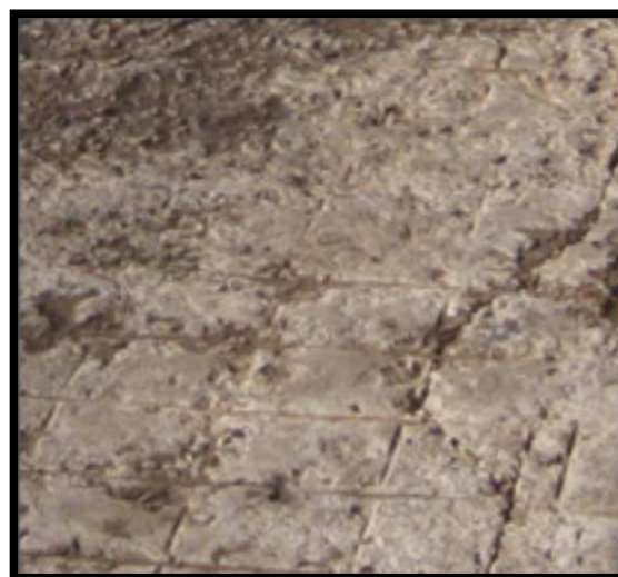
Figura 38. Ranurado por estampado de malla de acero en Corral de Espera. Piso con desgaste por uso.
