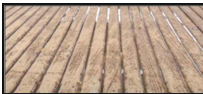
Figura 27. Ranurado paralelo en piso del corral de espera.
