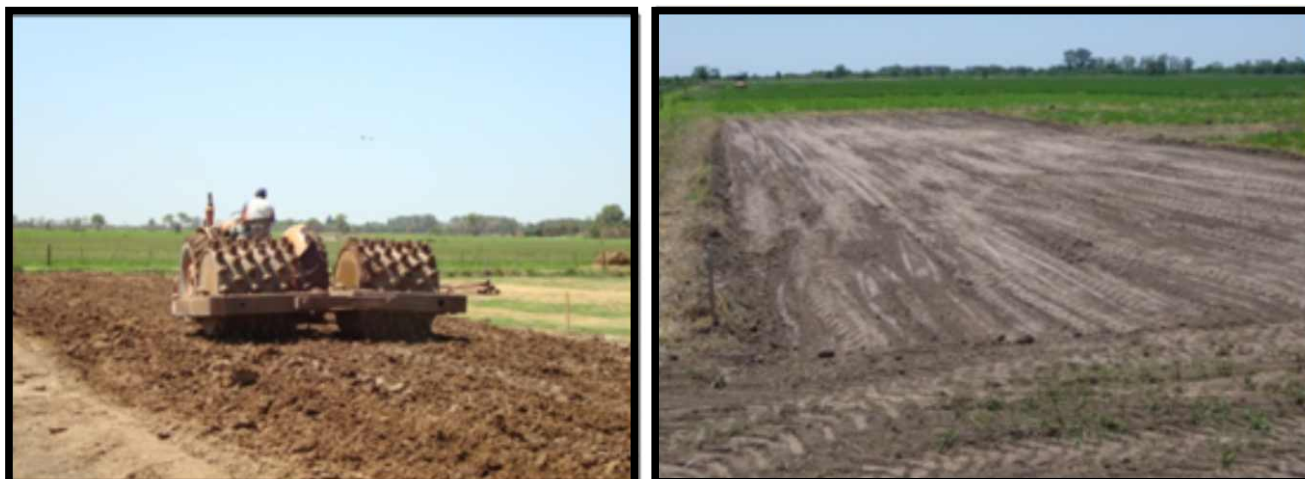
Figura 8. Base de tierra arcillosa (tierra colorada) compactada.
