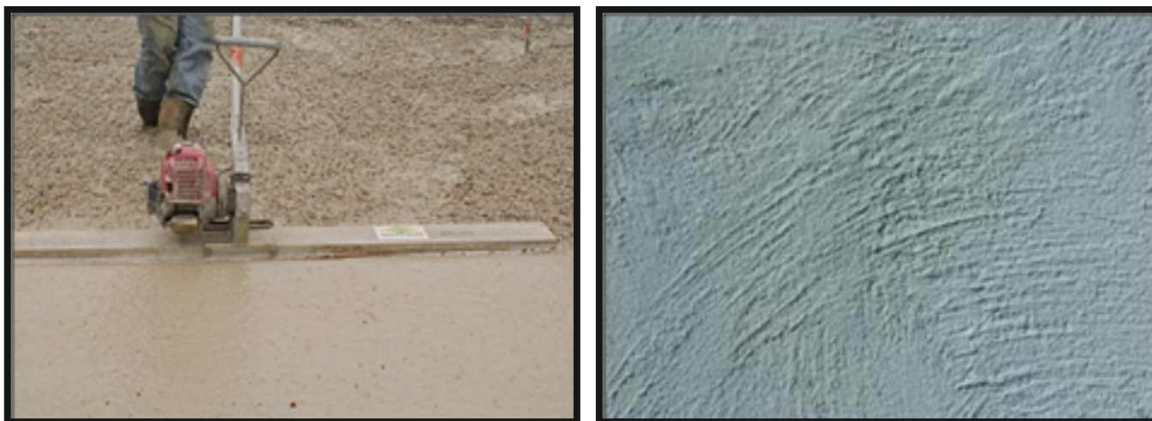
Figura 18. Terminación del hormigón fresco con fratás de madera. Foto izq: fratás de mango largo con vibrador incorporado (Fuente: GIE Lait-Viande de Bretagne, 2010). Foto der.: acabado logrado con fratás de mano (terminación a muñeca).
