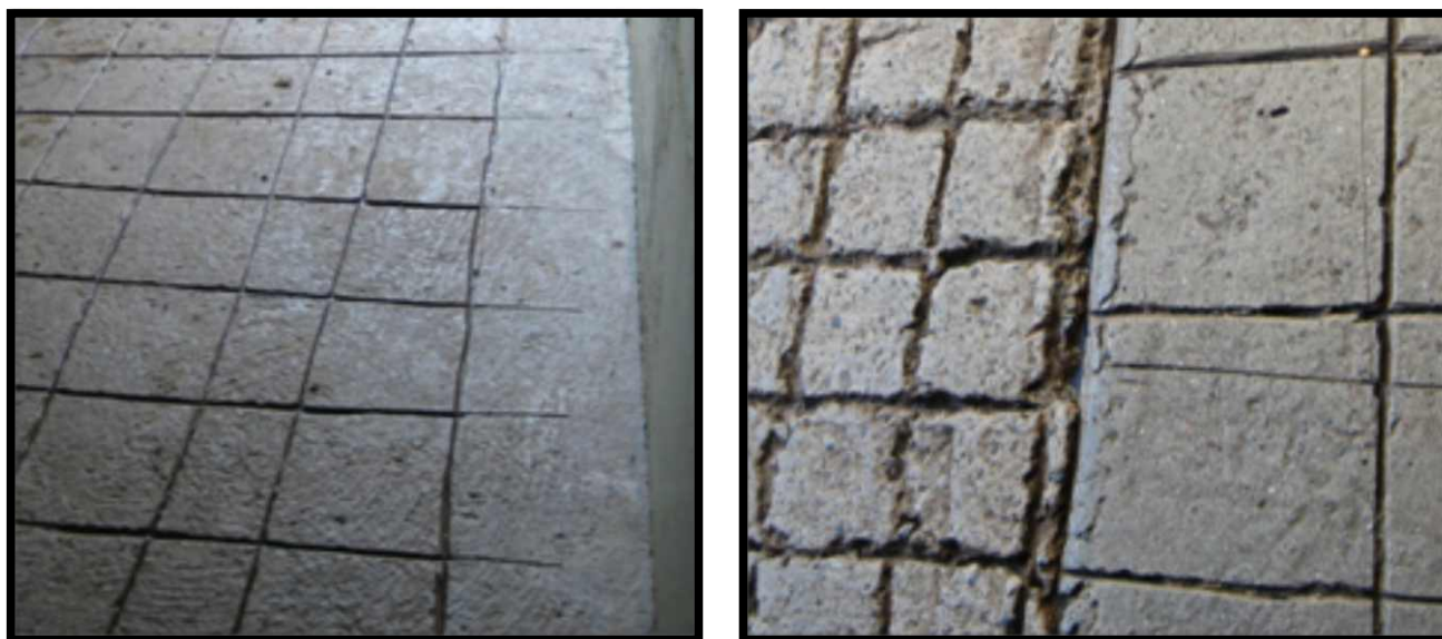
Figura 39. Ranurado con amoladora de mano, desprolijo y muy poco efectivo para evitar la caída de vacas.
