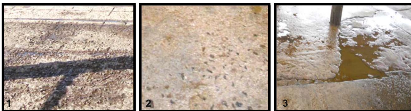
Figura 1. Exposición de los agregados debido a la pérdida de la pasta de cemento en corral espera.
