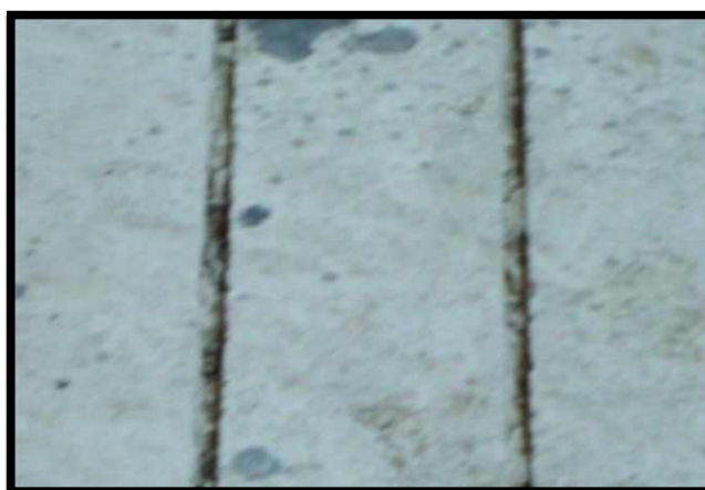
Figura 30. Ranurado con aserradora para pavimentos (foto izquierda). Acabado final de la superficie (foto derecha).
