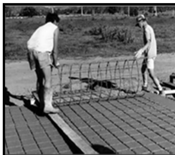
Figura 35. Estampado con malla de acero electrosoldada mediante rolo.
