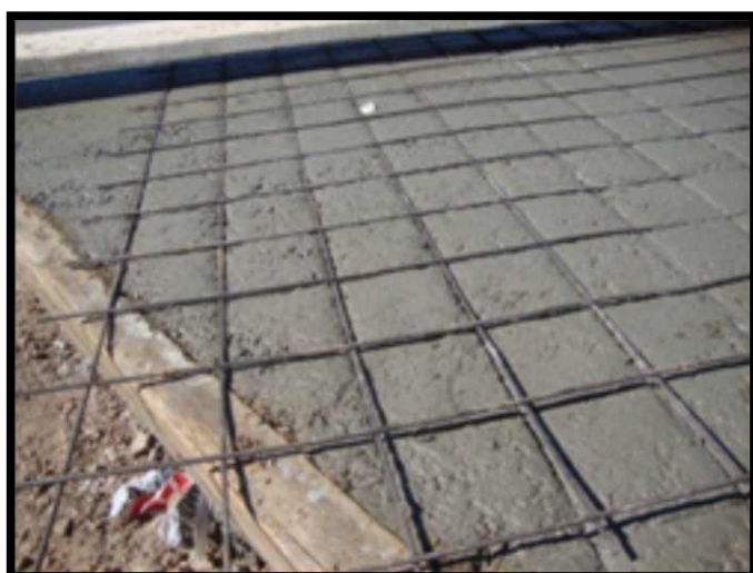
Figura 34. Estampado con malla de acero electrosoldada.
