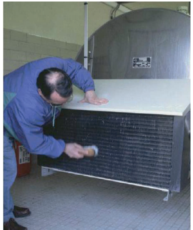
Figura 13. Limpieza de la superficie de intercambio del condensador del equipo frigorífico.
