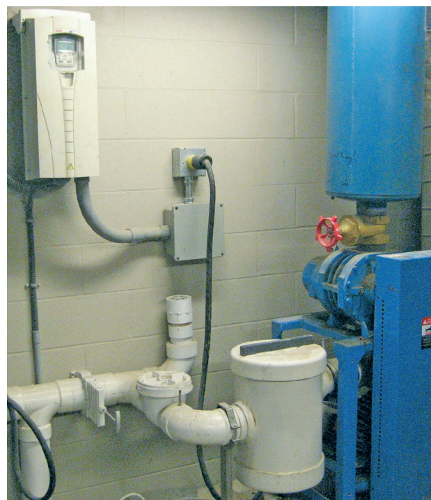
Figura 15. Controladores de velocidad variable instalados en bomba de vacío.
