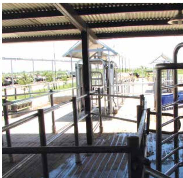
Foto 1 - Toma desde sala de ordeño hacia patio de espera. INTA-Rafaela
