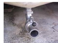
7. Controle el tanque de frío. Observe superficie interna y externa, entrada, salida y juntas.
