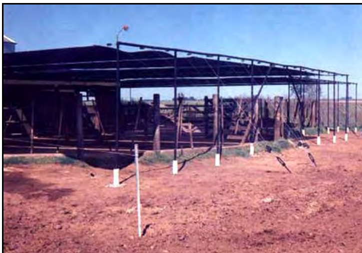
Figura 1.- Como pueden apreciar en la imagen no es muy complicado de llevar a cabo este tipo de protección.
