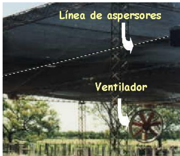
Refrigeración en el corral de espera
