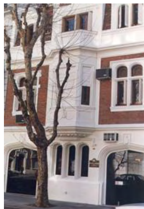
Fachada actual la sede de A.C.H.A. en Bs. As.
