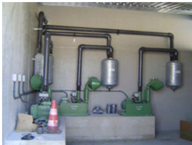
Bombas de vacío colocadas en serie
