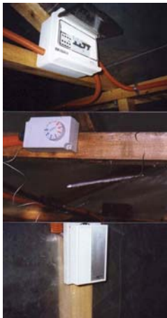
Fig.7 El invernadero debe contar con sistema de control térmico y de humedad.
