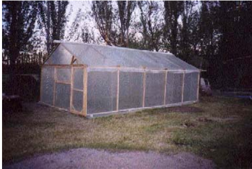
Fig. 6 Se puede iniciar con invernadero sencillo y crecer junto con la producción, como se puede observar en el invernadero tipo túnel .
