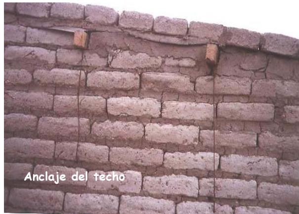
general de 90° lo que facilita la colocación del techo y le da firmeza. Si se utilizan paredes de adobe es necesario dejar algún tipo de anclaje en la pared para atar los tirantes (alambión, etc.). Este debe estar entre las a las 4-5 últimas hiladas de adobe.
