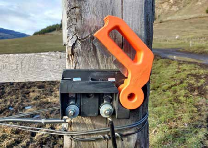
Figura 8.8. Interruptores para cerco eléctrico.
