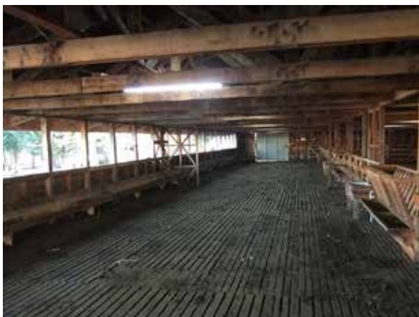
Figura 8.9. Piso de cobertizo ranurado.
