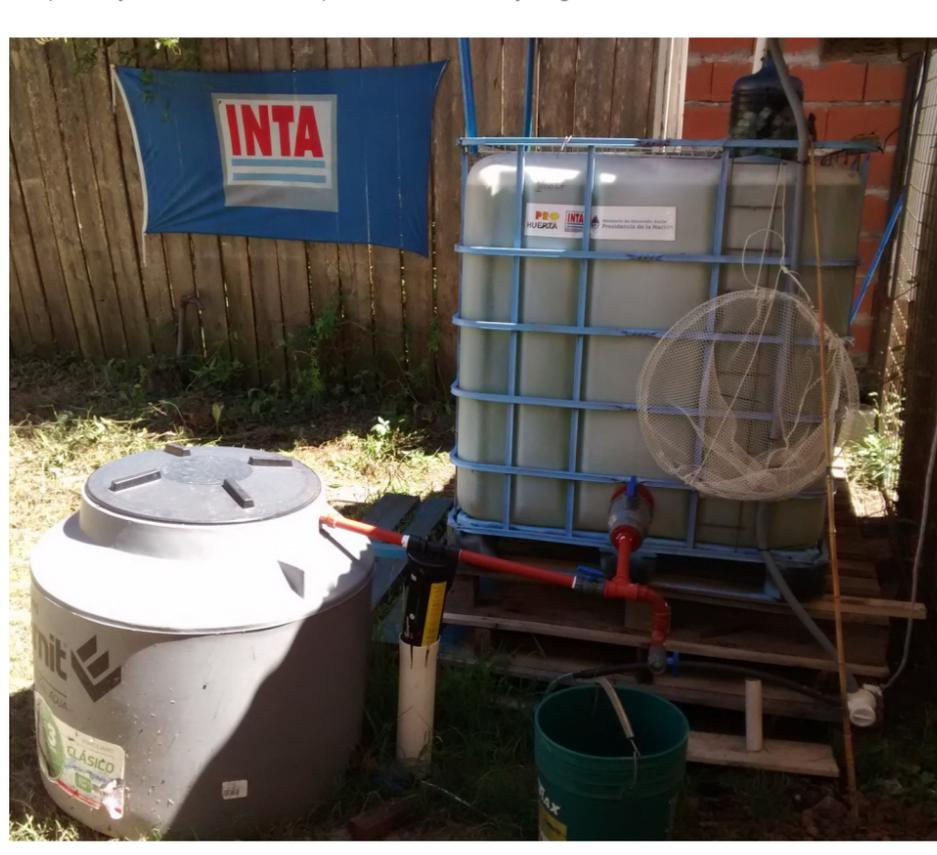
**2-Tanque secundario o reservorio:** Contenedor por el cual se suministra mediante bombeo agua al tanque principal y actúa de reserva de agua en el sistema.
