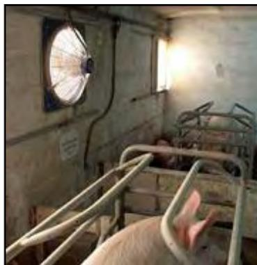
Figura 4.- Ventilación forzada.
