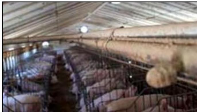
Figura 6.- Sistema de refrigeración por nebulización.
